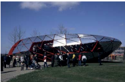
FIG. 12 Provincial Pavilion Floriade 2002, Hoofddorp; Kas Oosterhuis
