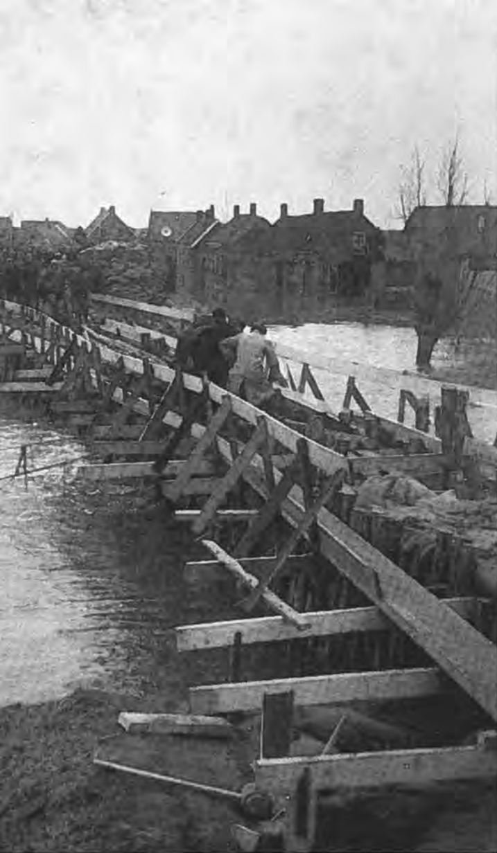
De dichting van het grote gat in de Lavendeldijk. Tussen een dubbele rij palen worden zandzakken gestort. — Foto mej. Pijl, Den Haag.
