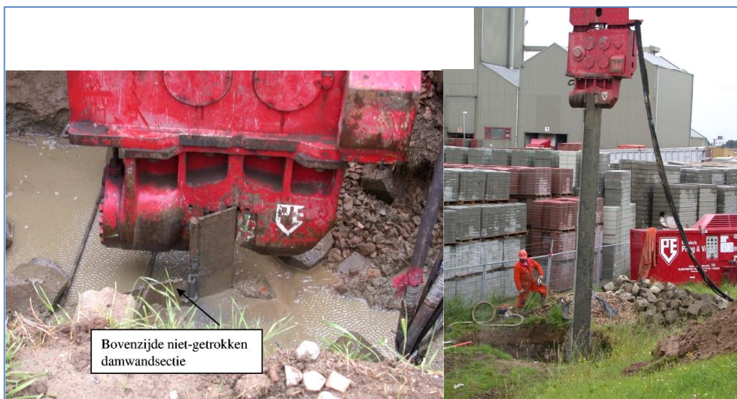
Figuur 6.2 Uitvoeren van het trekken van een damwandplank
