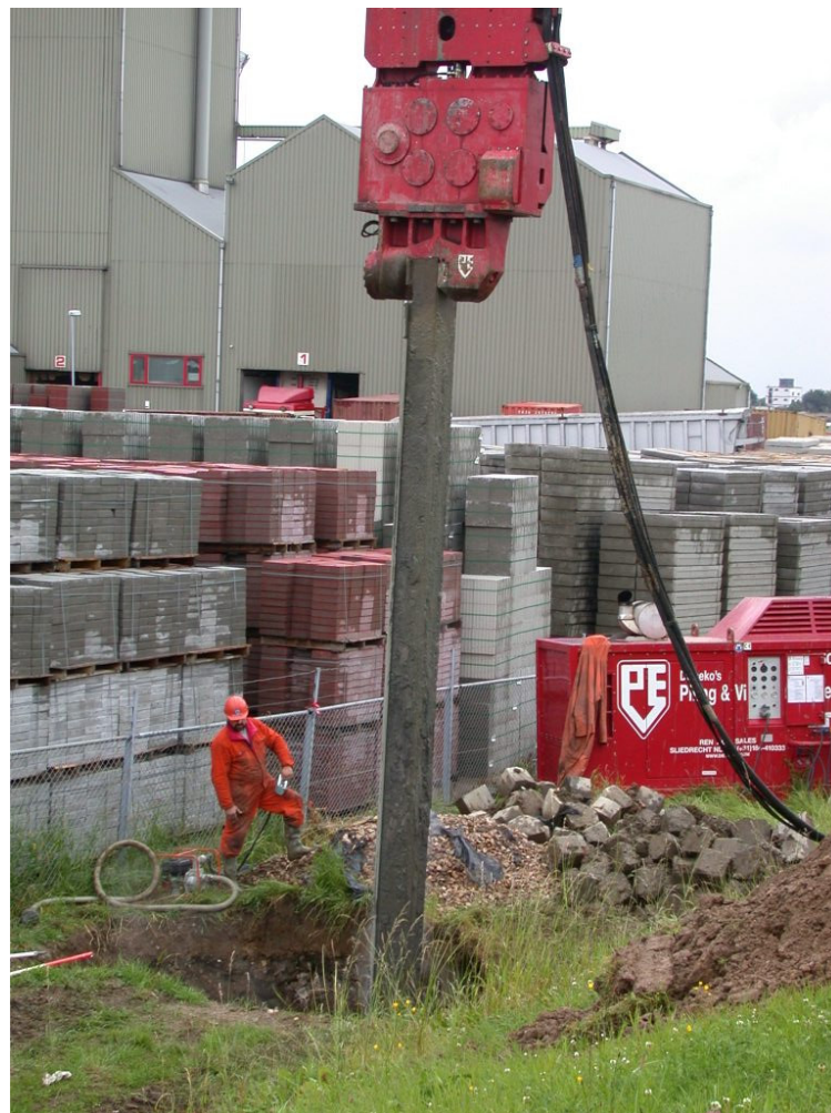
Figuur 1. Uitvoering van het trekken van de damwandsectie.
