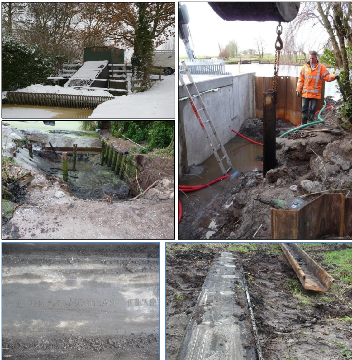
Figuur 6.8 Foto's locatie en getrokken damwandplanken in Giessenburg
