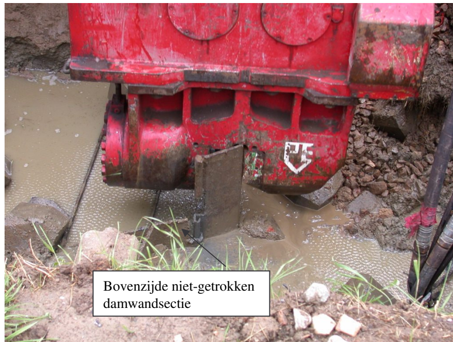
Figuur 3. Aanvang van het trekken van de damwand; foto geeft indruk van de hoogte van grondwaterstand.
