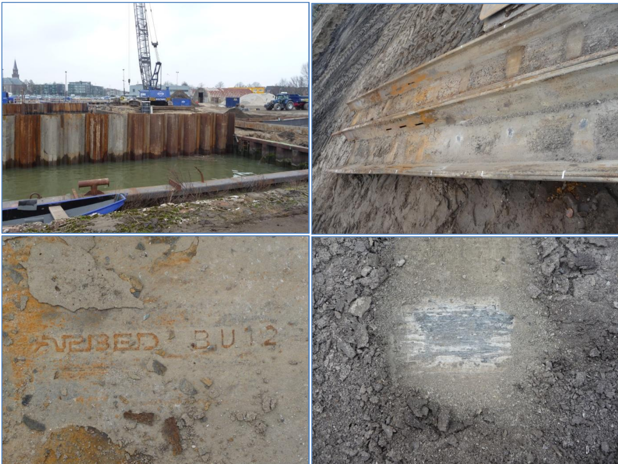
Figuur 6.15 Foto's damwandplanken Alblasserdam
