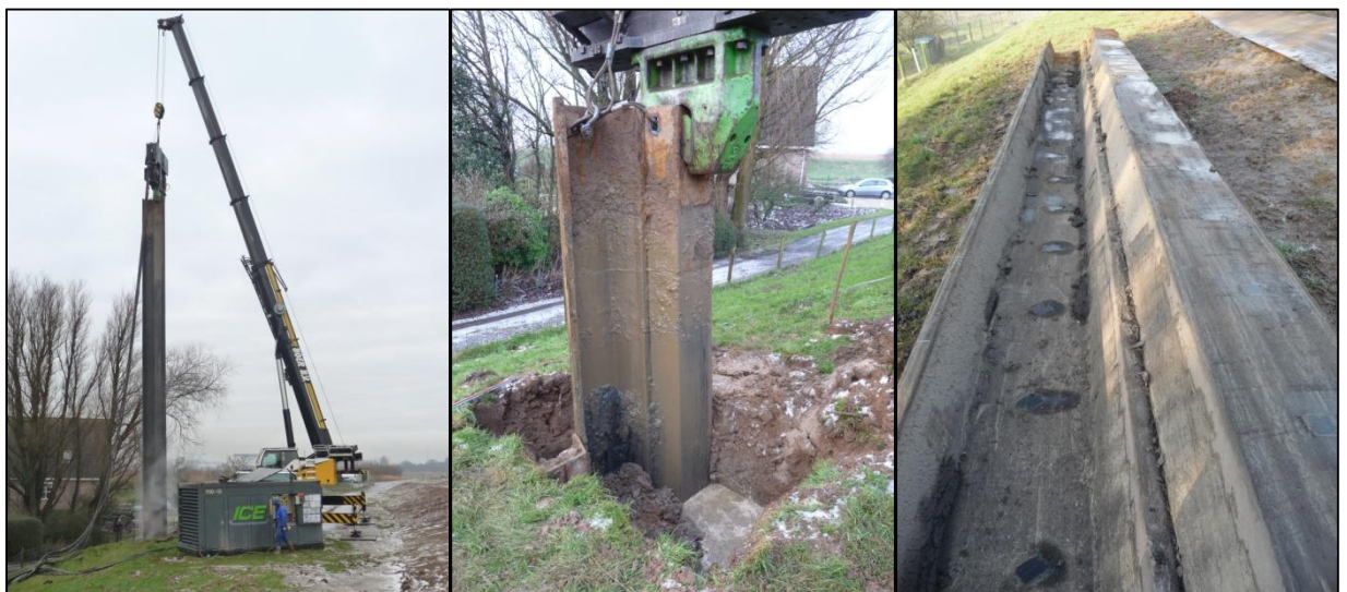
Figuur 6.11 Foto's getrokken damwandplank Nieuw Lekkerland West, Lekdijk 470
