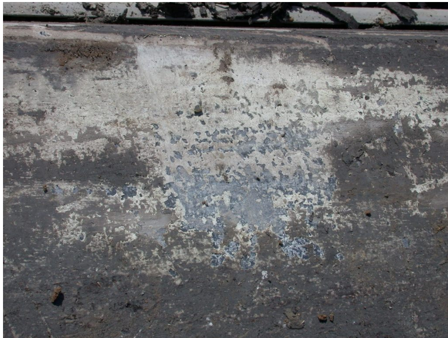
Figuur 5. Gedeeltelijke reiniging van het damwandoppervlak.
