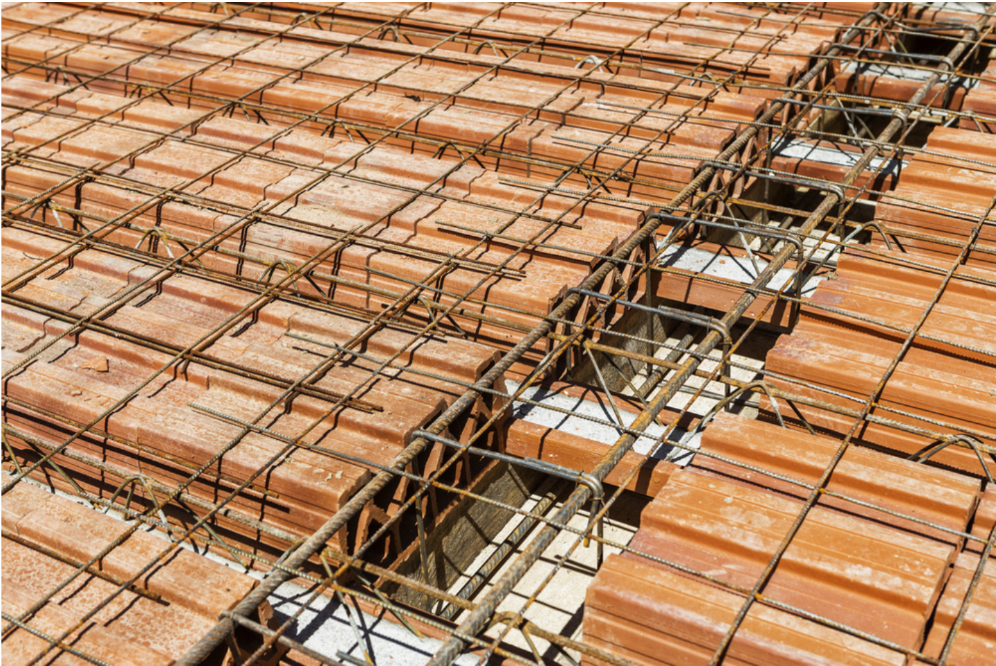
The floor system before pouring the concrete. From “Innovaciones en el Sistema de Vigueta y Bovedilla de Barro” (El Heraldo, 2023).
