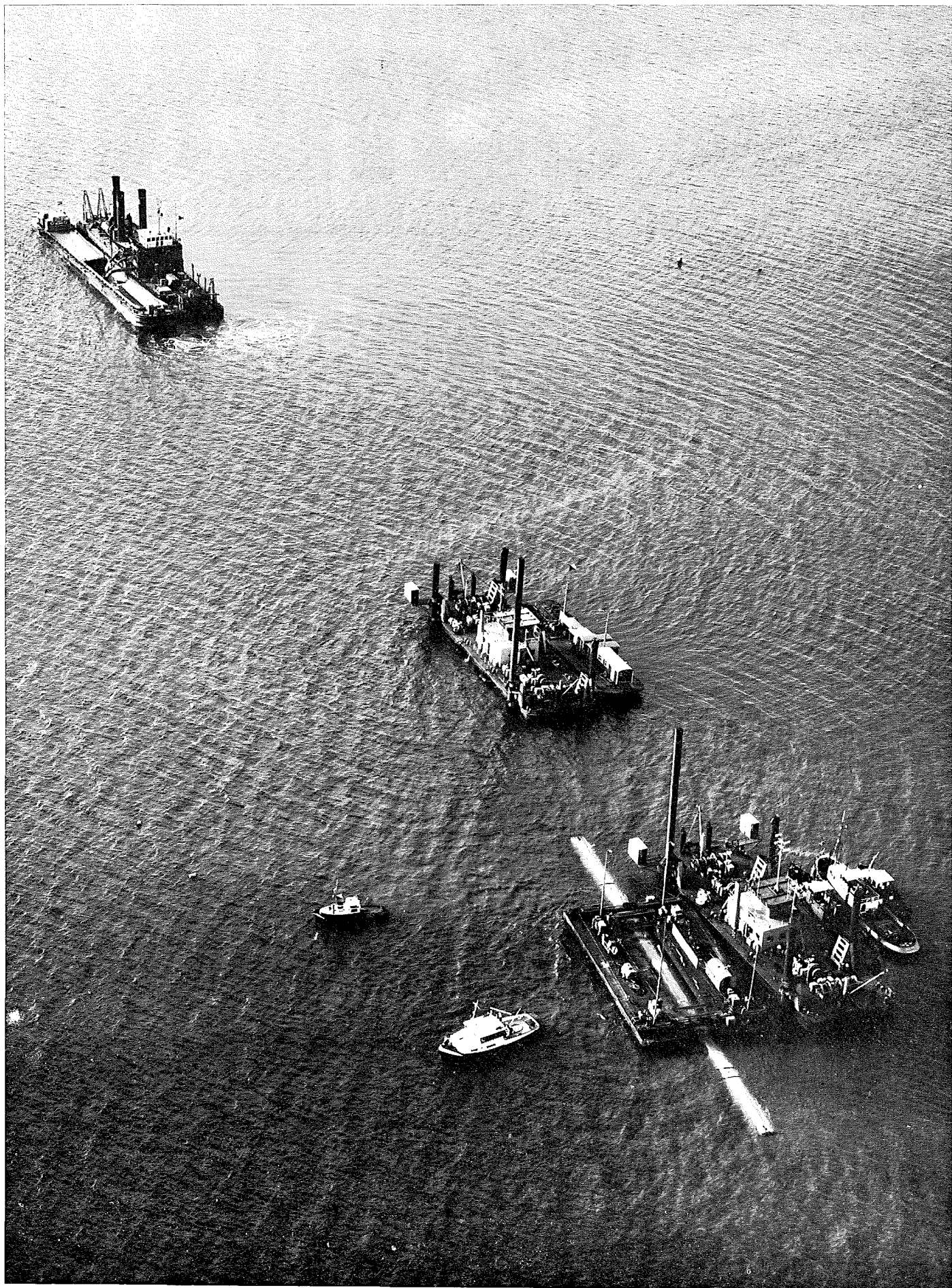
Overnemen van een tunnelement door de spudpontons
