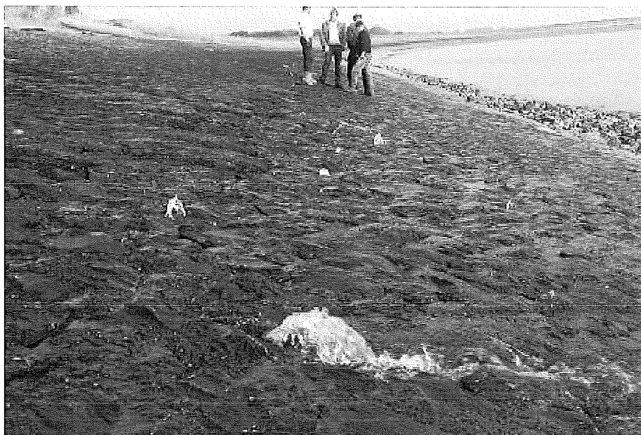
Figuur 4.8 Uittredend water door de toplaag
