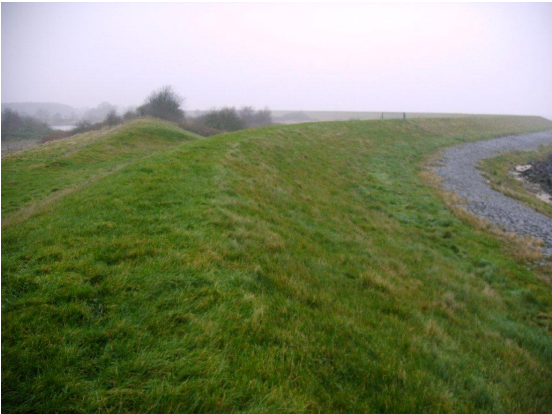
Figure 2.24. Wieringermeerdijk, facing the IJsselmeer.
