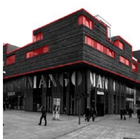
Individuele woningen zijn zichtbaar in de gevel.
