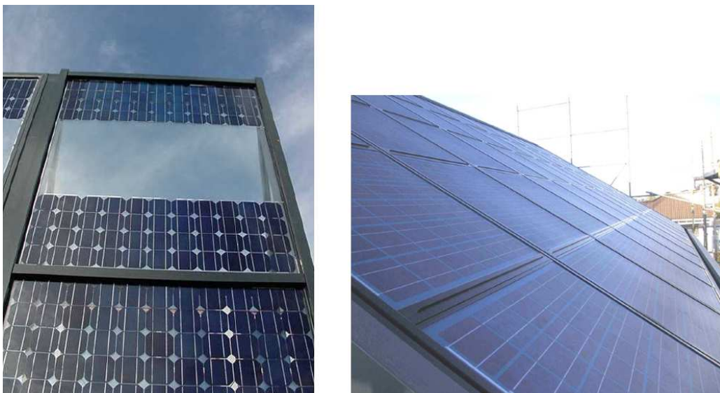
Fig. 4.21 Links de PV-vliesgevel van Oskomera, rechts Just-Roof van MSK Corporation
