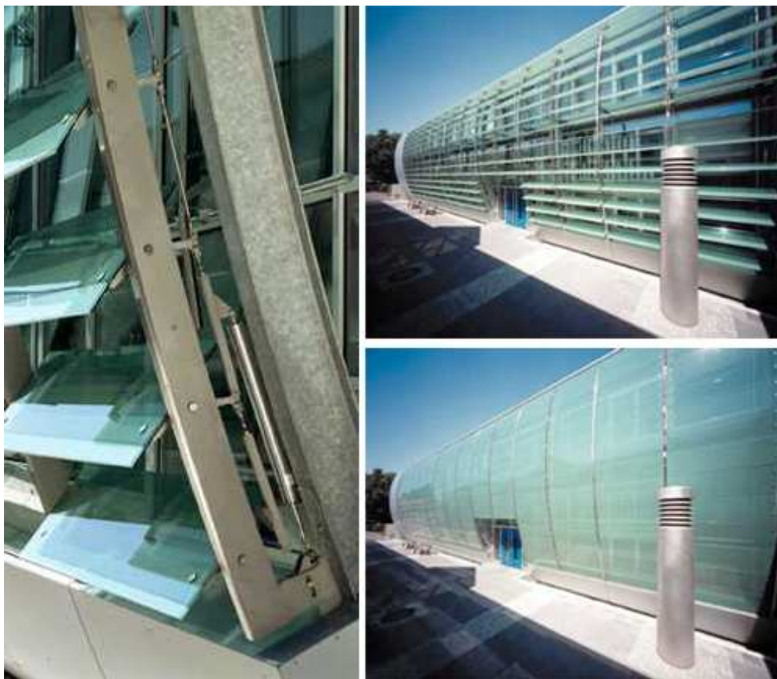
Fig 2.14 Buitenzonweringsysteem van Colt, kantoorgebouw van Grünewald GmbH te Bocholt (D.)
