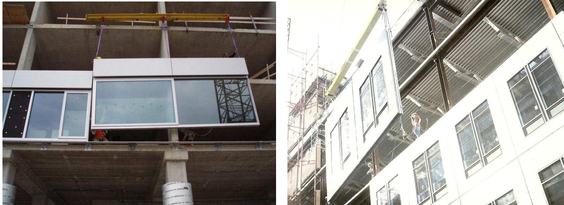
Fig. 3.4 Montage van gevelelementen
