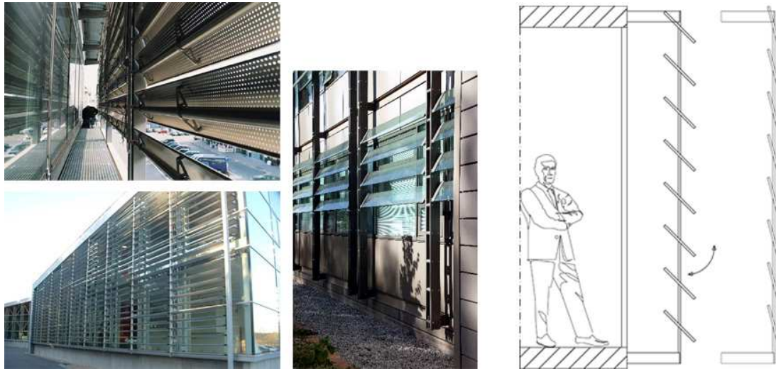
Fig 2.2 Buitenzonwering met beweegbare horizontale lamellen [www.coltgroup.com]
