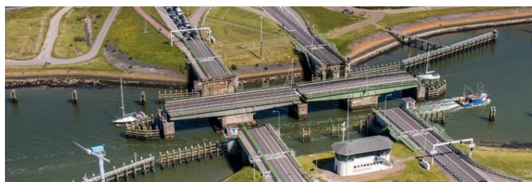
Figure 2.2 Swing bridge, Afsluitdijk (Afsluitdijk, 2017)
