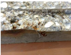
Crack position N°3
