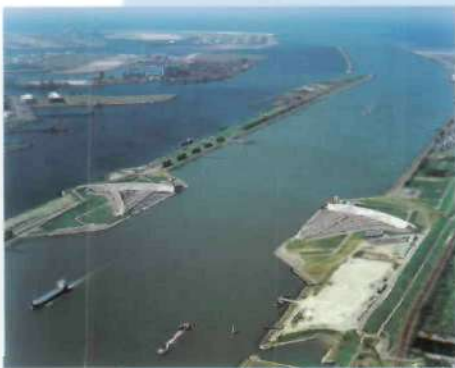
Stormvloedkering in Nieuwe Waterweg
