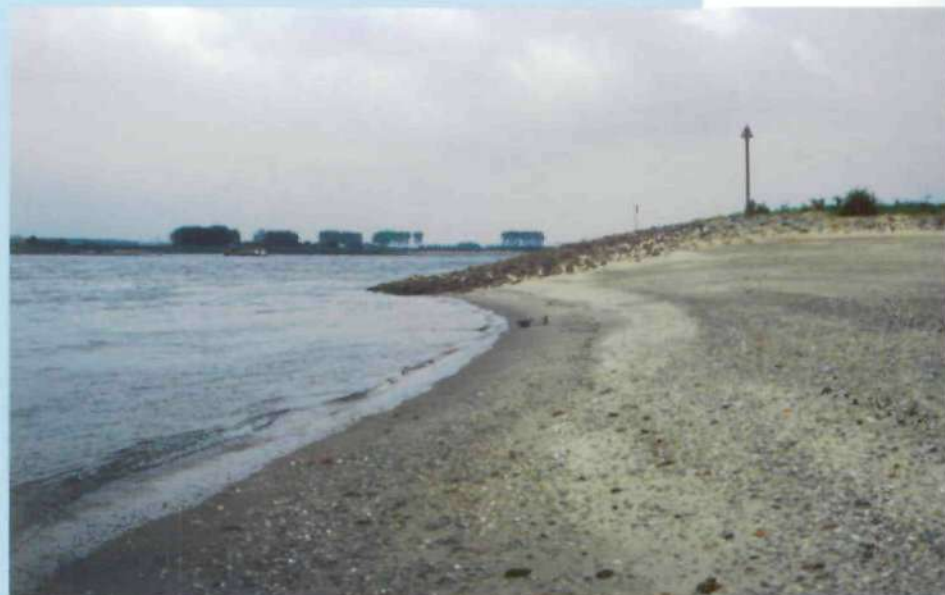
Krib in bovenstrooms traject van de Waal
