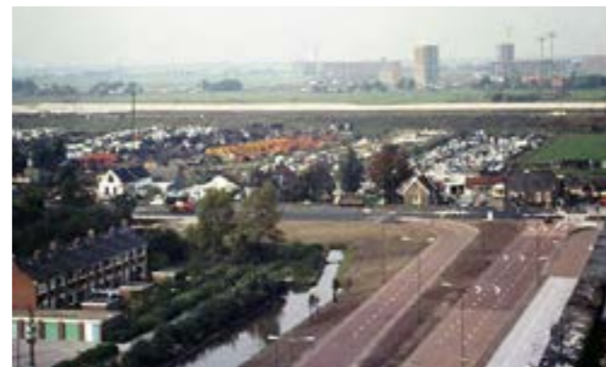
Tussen Ommoord en Het Lage Land wordt grote infrastructuur gebouwd waarlangs zich direct functies voegen die niet in de woonwijken thuishoren. (Foto: D.L. Krieger, Collectie Historische Vereniging Prins Alexander / Collection Historical Association Prins Alexander) The large infrastructural works constructed between Ommoord and Het Lage Land are flanked by functions that do not belong in residential neighbourhoods.
