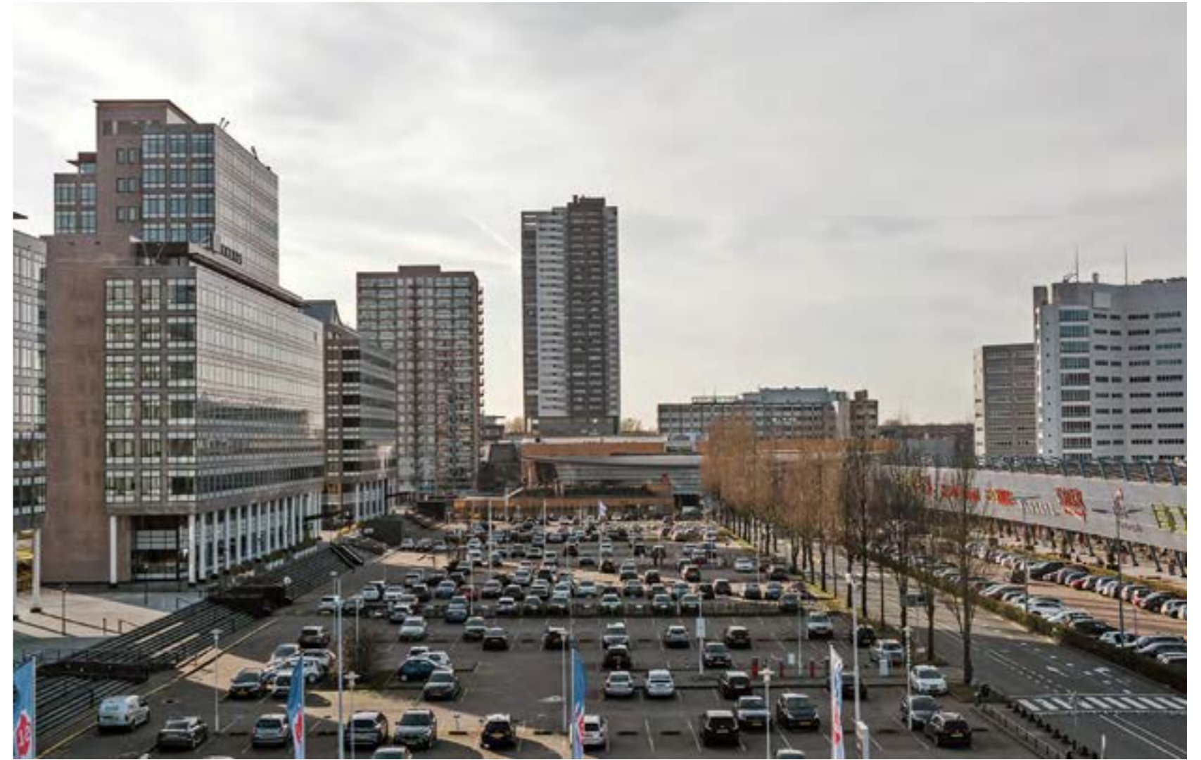
Parkeerplaats voor kantoren en Alexandrium aan de Watermanweg. Parking spaces for offices and Woonmall Alexandrium on Watermanweg.
