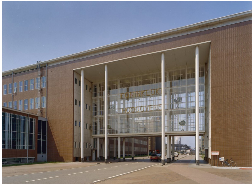
Afbeelding 1. Wal, A.J. van der (2002-06). Overzicht voorzijde poort in het hoofdgebouw [Foto].
