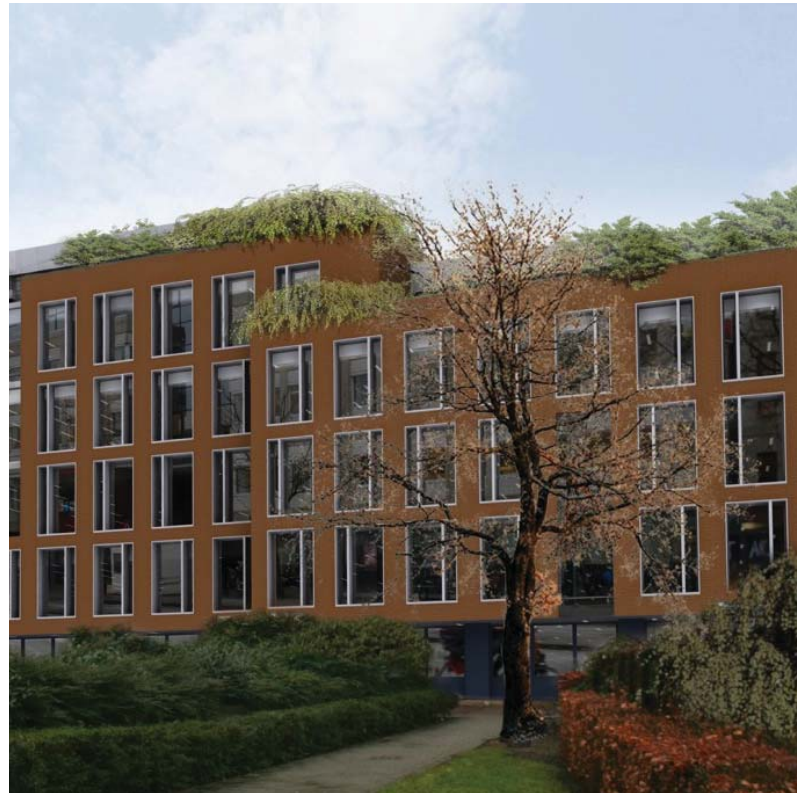
KRAAUVANGER PROVINCIEKANTOOR, HAARLEM
