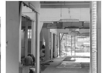
EN LOS PRÓXIMOS DÍAS COMENZARÁ LA DEMOLICIÓN.
