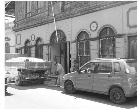
LOS TRABAJOS EN LA CASONA PASCAL COMENZARON A FINES DE DICIEMBRE.
