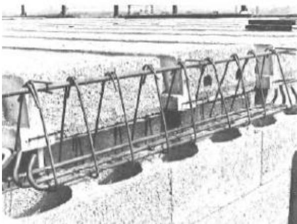
Figuur 2.1 MUWI systeem, lichte betonnen blokken die gevuld kunnen worden met beton (Loukopoulou, 2012, p. 43).
