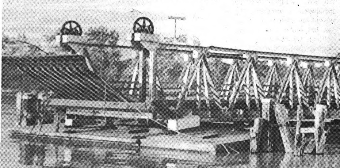
De ponton waarop de uit staal opgetrokken steiger rust kan elk moment geheel van zijn plaats raken.
