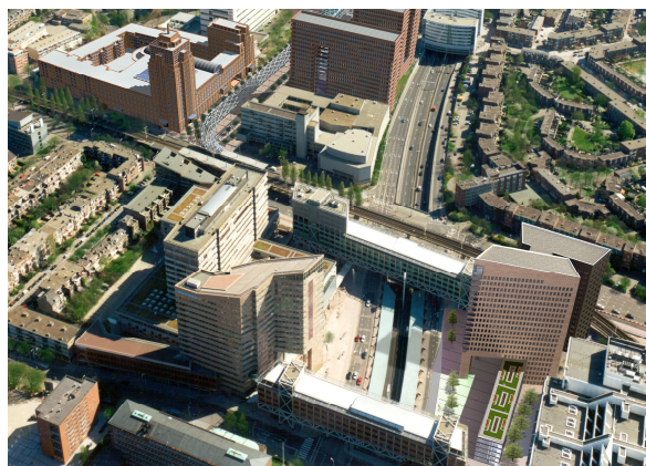
Figuur 71: zicht vanaf Malieveld (Multi vastgoed)
