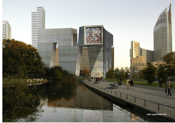
Figuur 74: zicht vanaf Malieveld (Multi vastgoed)
