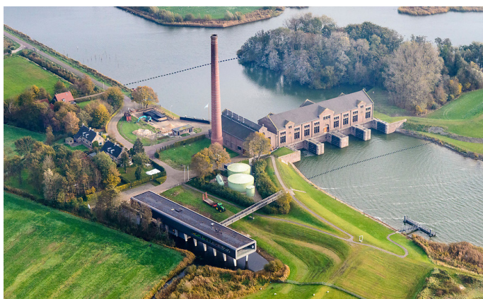
Afb. 13. Vogelvluchtperspectief van het op betonnen palen gebouwde bezoekerscentrum, welke door middel van een loopbrug verbonden is met het Woudagemaal (Swart, 2018)
