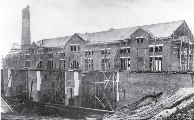
Afb. 2a. De zuidgevel van het Woudagemaal in de stijgers tijdens de bouw (Tresoar Fotoarchief, 1918)
