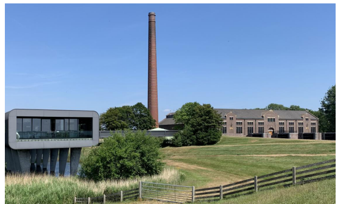
Afb. 11b. Het Woudagemaal en het bezoekerscentrum vanaf de zijde van het IJsselmeer (Hijkema, 2020)
