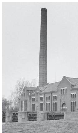
Afb. 8d. De schoorsteen met metalen banden (Rijksdienst voor het Cultureel Erfgoed, 1975)
