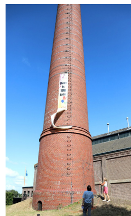
Afb. 8e. Het 100-jarig bestaan van de schoorsteen (Ir. D.F. Woudagemaal, 2019a)
