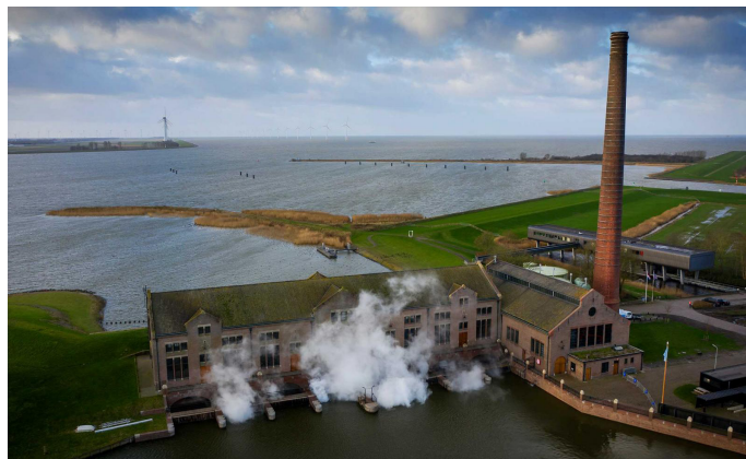
Afb. 1. De noordgevel van het Woudagemaal, inclusief het bijbehorende bezoekerscentrum, en het IJsselmeer op de achtergrond (van Lonkhuijse, 2020)
