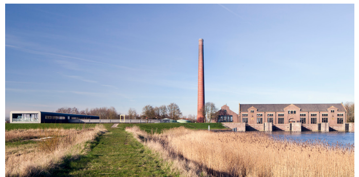
Afb. 16. De zuidgevel van het Woudagemaal en het in de omgeving geïntegreerde bezoekerscentrum (Rijksdienst voor het Cultureel Erfgoed, 2017b)
