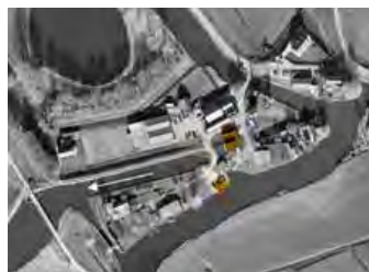
ILLUSTRATIE 4.38 Tussen-boezemgemaal Bovengemaal.
