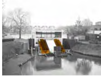
ILLUSTRATIE 3.39 Poldergemaal met vijzel: deze waterwerken staan altijd boven aan de dijk, zoals hier het gemaal Leyens. De opmaattechniek, de vijzel is goed zichtbaar. Een stalen vijzel kan maximaal een hoogte van 4-5 meter overbruggen en bestaat tegenwoordig veelal uit een wormschroef van twee of drie gangen die in elkaar gedraaid zijn.
