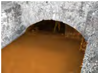
ILLUSTRATIE 2.3 Watertunnel, de ondergrondse kanalisatie.
