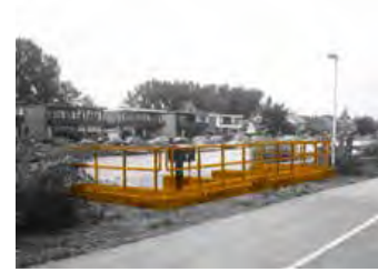
ILLUSTRATIE 3.46 Uitlaat: waterwerk dat aan de bovenkant van de dijk ligt en de plek versterkt waar het water, meestal onder de waterlijn, vanuit het gemaal in de boezem of het buitenwater stroomt.
