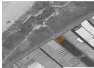
ILLUSTRATIE 4.35 Boezemgemaal Vlotwateringen.
