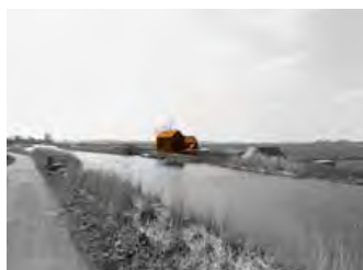
ILLUSTRATIE 7.117 Het gemaal Binnenwegsepolder fungeert, ook al is het heel klein, door zijn uitzonderlijke positie op de Rottedijk als 'landmark' met een reikwijdte tot aan de horizon.
