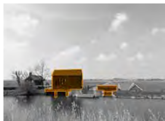
ILLUSTRATIE 7.78 De poldergemalen Binnenwegsepolder boven op de Rottedijk.
