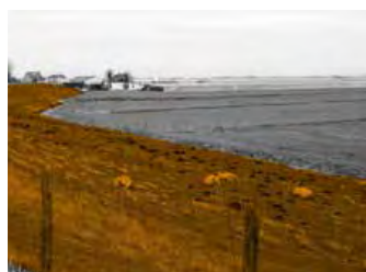
ILLUSTRATIE 7.72 De Rottedijk met zijn flauwe helling. Soms ligt er op halve hoogte van de veendijk een binnenboezem-relict.
