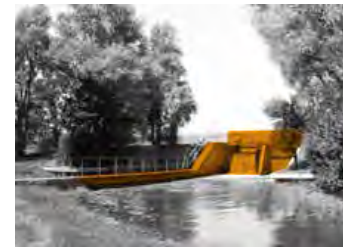
ILLUSTRATIE 3.50 Inlaat: waterwerk dat water gecontroleerd van een hoog niveau naar een laag niveau brengt. De inlaat kan open en zichtbaar zijn en bij een groot hoogteverschil uitgewerkt worden als watertrap of waterval, zoals hier in de Flevopolder.
