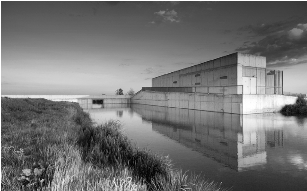
ILLUSTRATIE 8.18 Het gemaal Onnerpolder is onderdeel van de promenade architecturale (een route die zorgt voor een ruimtelijke beleving) die zich tot in het landschap uitstrekt.
