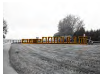
ILLUSTRATIE 7.77 De opvallende constructie van het Bleiswijkse Verlaat.
