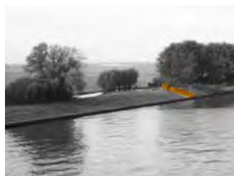
ILLUSTRATIE 3.42 Elektrisch poldergemaal: deze aandrijftechniek kent geen specifiek uiterlijk en maat. Twee uitersten zijn het poldergemaal Lely en de anonieme kastje langs het Amsterdam Rijnkanaal.
