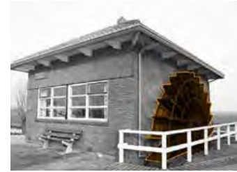
ILLUSTRATIE 3.40 Dieselmengemaal met scheppraad: vele combinaties van aandrijving en opvoering zijn mogelijk zoals hier bij het gemaal Langerak.
