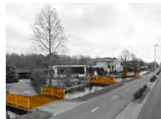
ILLUSTRATIE 7.65 De Boezemvaart met langs de vaart bebouwing die door tal van bruggen worden ontsloten.
