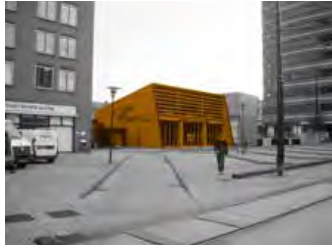
ILLUSTRATIE 7.84 Het boezemgemaal Schilthuis gezien vanaf de kant van het buitenwater. Het gemaal ligt verscholen achter hoge woongebouwen.
