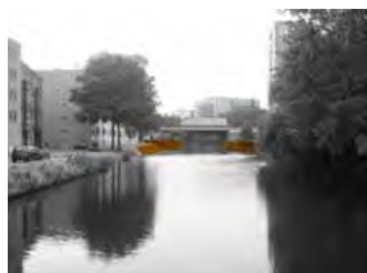
ILLUSTRATIE 7.35 De trechtervormige kade voor het gemaal.
