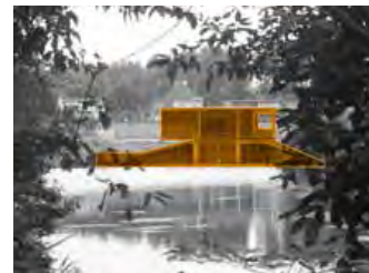
ILLUSTRATIE 7.83 Het gemaal Ommoord heeft een hoge gevel aan de polderzijde, en lage gevel aan de Rottezijde.
