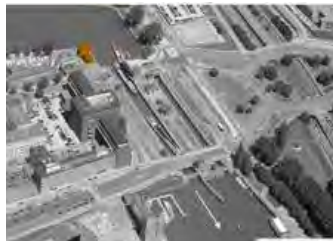
ILLUSTRATIE 4.34 Boezemgemaal Parksluizen en sluizen.
