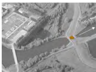
ILLUSTRATIE 4.27 Boezemgemaal/energiecentrale Diemen.
