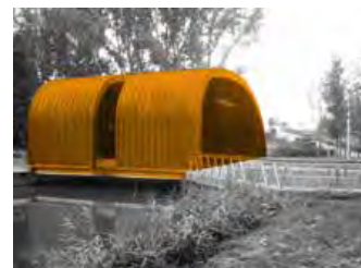
ILLUSTRATIE 7.80 Het gemaal Lansingerland is als bouwwerk opvallend en staat ver af van de Rotte.
