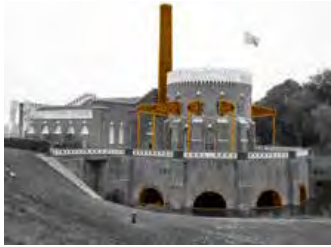
ILLUSTRATIE 3.38 Stoomgemaal: is een imposant en krachtige installatie die water van een lager naar een hoger waterpeil brengt. De stoomgemalen Cruquius en Wouda (beiden Unesco werelderfgoed) zijn groot en visueel opvallend. Het uiterlijk van de waterwerken wordt bepaald door de schoorsteen en de massieve uitvoering van het gebouw, soms is de aandrijftechniek zichtbaar.
