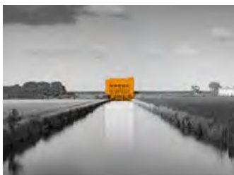
ILLUSTRATIE 3.41 Elektrisch poldergemaal: deze aandrijftechniek kent geen specifiek uiterlijk en maat. Twee uitersten zijn het poldergemaal Lely en de anonieme kastje langs het Amsterdam Rijnkanaal.
