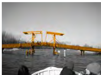
ILLUSTRATIE 7.97 De Pekhuisbrug is van veraf zichtbaar en door zijn openingsmechanisme opvallend aanwezig.
