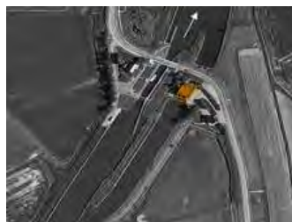
ILLUSTRATIE 4.14 Boezemgemaal De Waakzaamheid.
