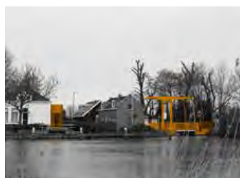
ILLUSTRATIE 7.119 Het gemaal Berg en Broek (oranje vlek links op de foto) is niet als zodanig te herkennen. De ophaalbrug markeert de verbinding tussen tussenboezem en boezem.
