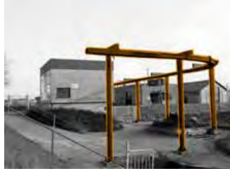
ILLUSTRATIE 3.45 De moderne gemalen zijn voorzien van een vuilvang. De bewegende 'hark' komt automatisch in actie als groef materiaal in het polderwater ligt en verwijdert deze.
