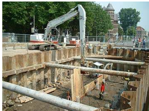
Fig. 3.1 Keerconstructie met damwanden
