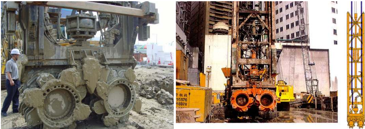
Fig. 6.2 Diepwand frezen
