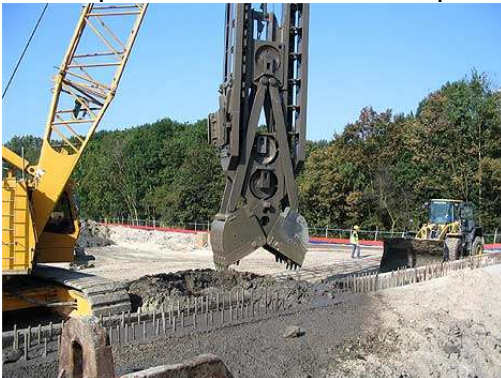
Fig. 6.1 Diepwandgrijpers
