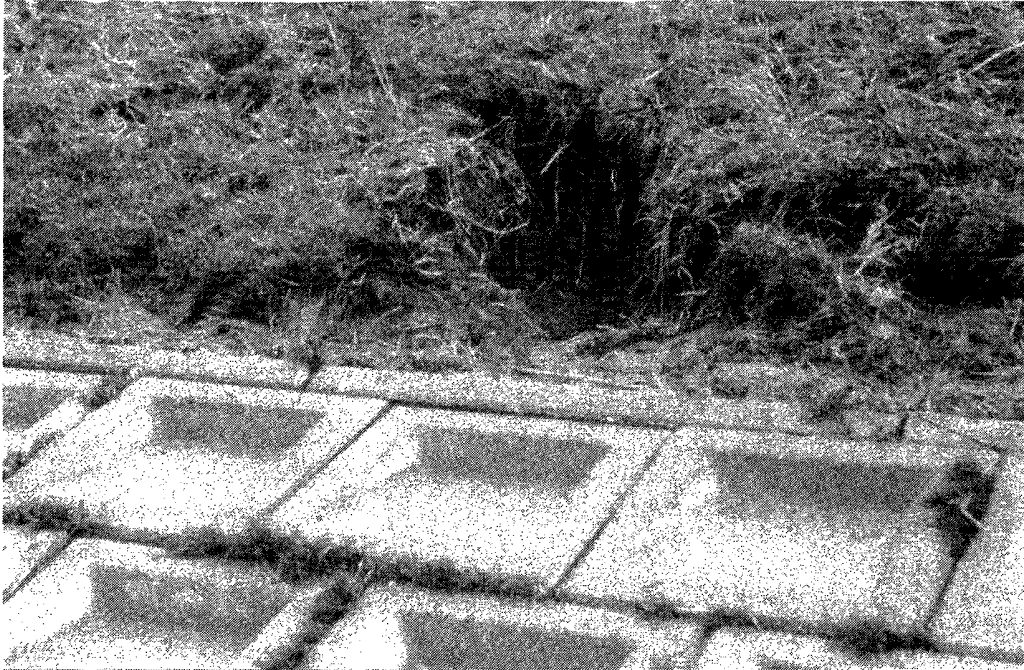
Foto 7 Erosie van gras vanwege het ontbreken van doorgroeistenen
