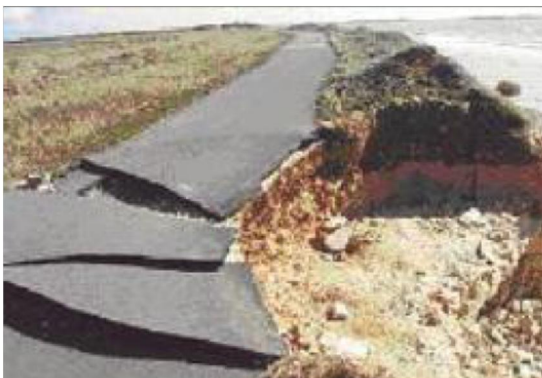
Figuur 3.4 schade bij de overgang van een asfaltweg en een dijk (Kolen et al. 2010, bron: Pijpers 2013)
