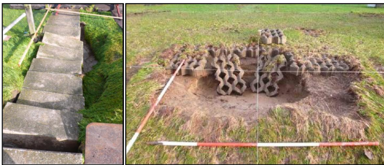
Figuur 4.2 Proefvakken na het testen met de golfklapgenerator. Links: trap in het dijktalud, rechts: horizontale overgang met doorgroeistenen (bron: Deltares, 2013)
