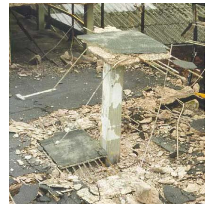
Figuur 25: Ponsschaden in praktijk.
