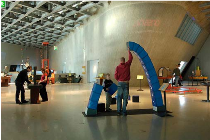
Figuur 10. Betonnen kegel pons door de eerste verdieping svloer om het dak te dragen.
