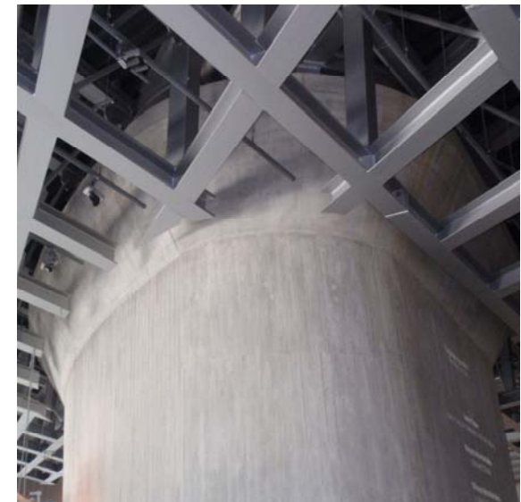
Figuur 31: Zwevend Vakwerk van de stalen dakconstructie.
