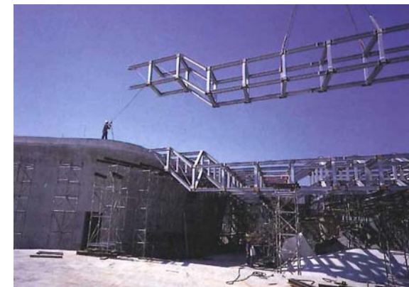
Figuur 32: Het in positie brengen van het voorgemonteerde stalen dak.
