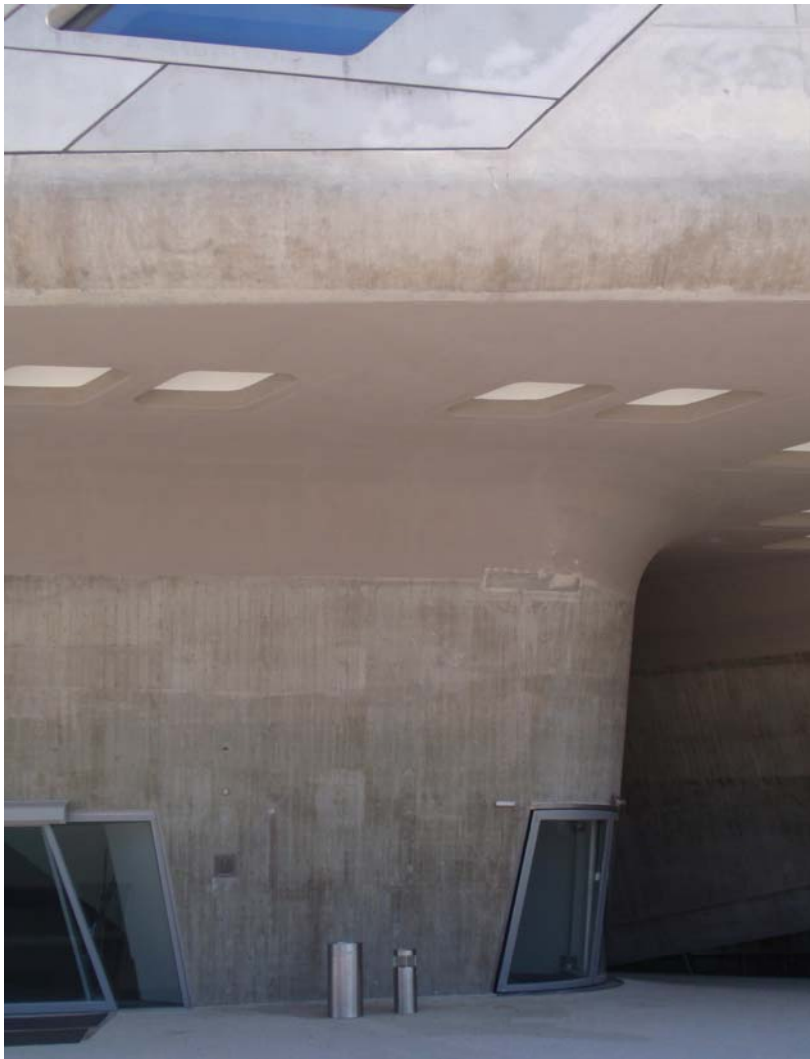
Figuur 26: Onsubtiële overgang van kegel in verdieping vloer.
