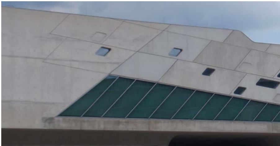
Figuur 30: Stortnaden doen afbreuk aan de façade als geheel.
