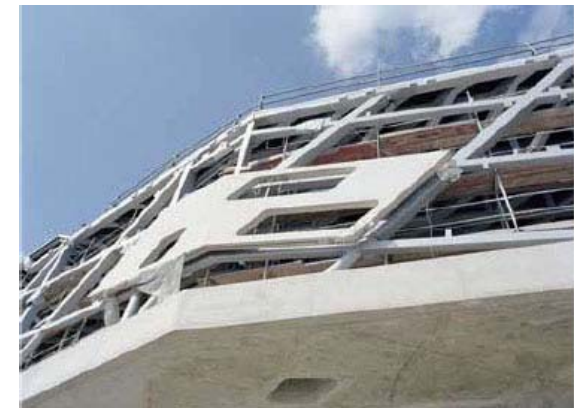
Figuur 18: Montage van de trapeziumvormige betonnen raamelementen aan de stalen constructie.
