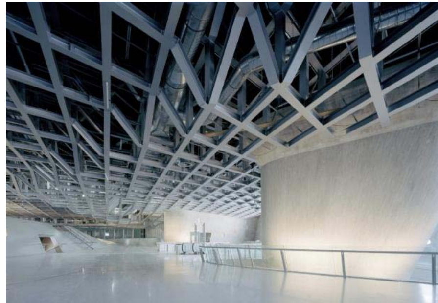
Figuur 20: Stalen dakconstructie in het gebouw.
