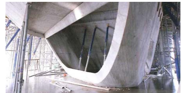
Figuur 15: Onderstempeling van een individueel onstabile kegel.
