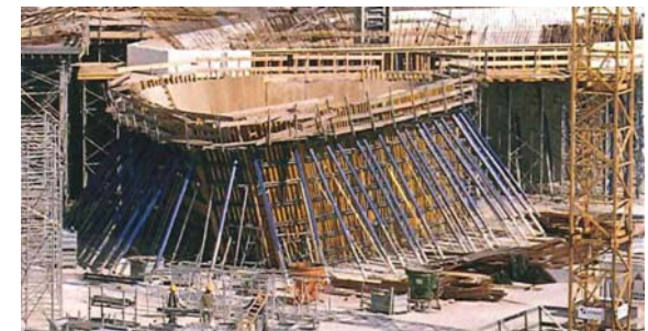
Figuur 14: Onderstempeling van de bekisting van een kegel voor de stort.
