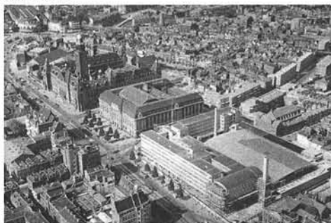
Coolsingel gezien vanuit het Zuiden, 1939. Aan de rechterzijde de "drie-eenheid van Stadhuis, Postkantoor en Beursgebouw"
