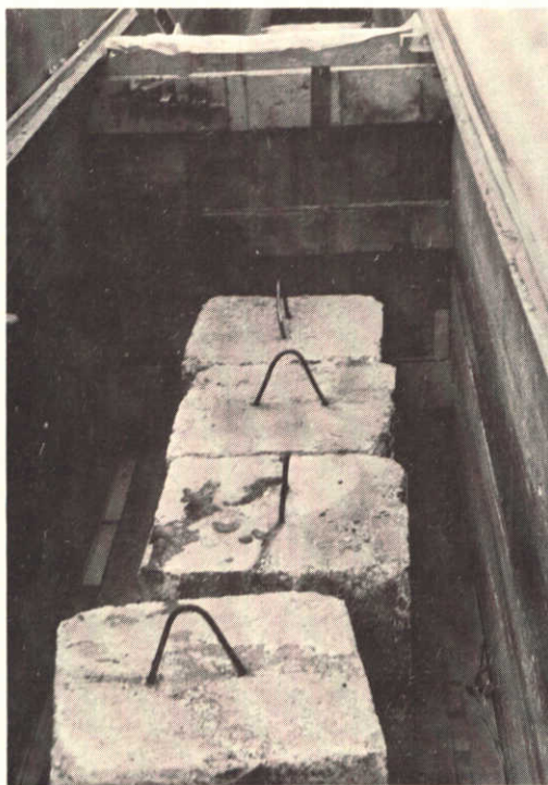
T7 "caisson" met ballast
