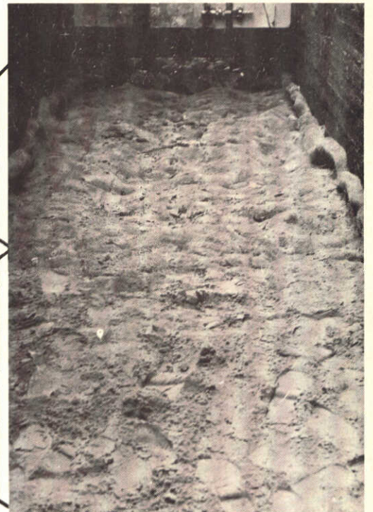
zandafzetting benedenstrooms van de caisson (bestorting verwijderd)
