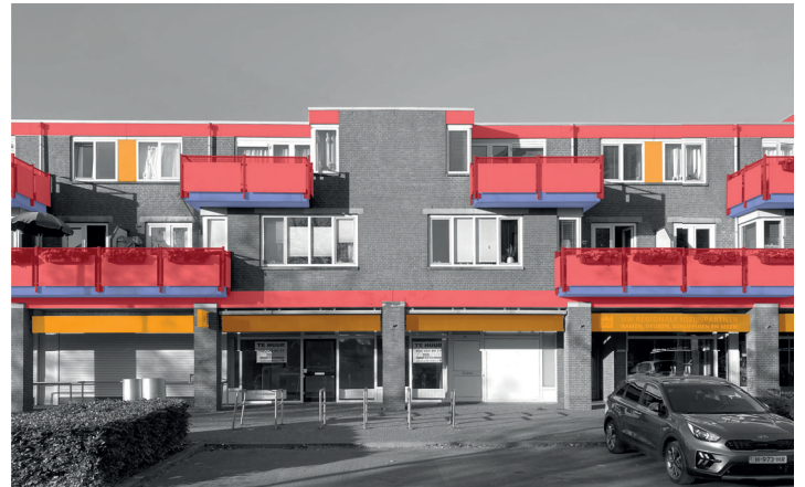
De Meerstraat, architect unknown - 1985
