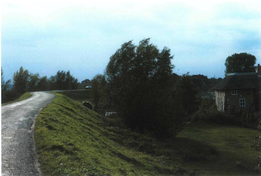
De dijk als landschapselement op zichzelf (Waardenburg, voor dijkverzwaring)
