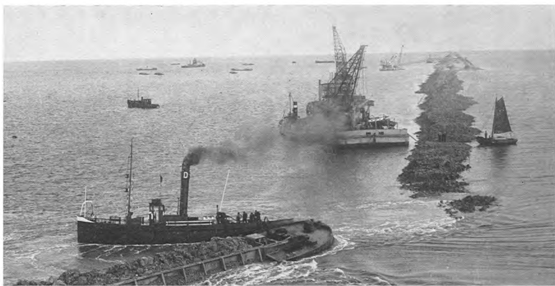
Keileem storten in het noordelijke sluitgat van de Wieringermeerdijk tijdens eb.
