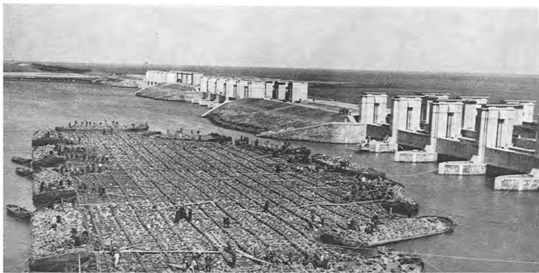
Aanbrengen van groot zinkstuk voor de spuisluisen te Den Oever.
