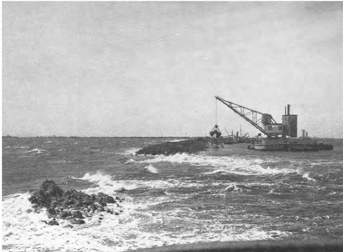
Stroomloop over de keileemdams in het sluitgat van de Wieringermeer.
