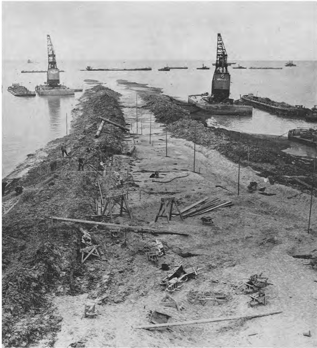
Het aanbrengen van de kleibekleding, krammen en zetten van steen op de in aanbouw zijnde Afsluitdijk in het gebied van de Middellgronden.
