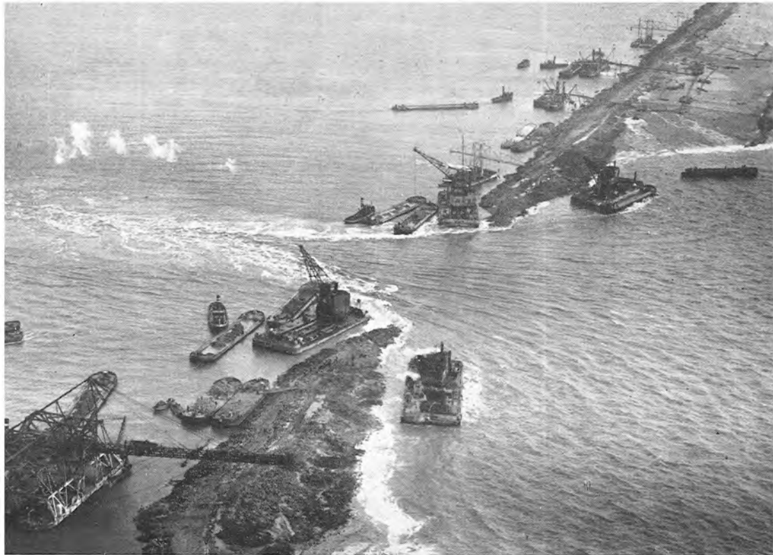
Het sluitgat Middelgronden; na het ontstaan van een diepe krater is de keileemdamm tijdelijk verlegd.
