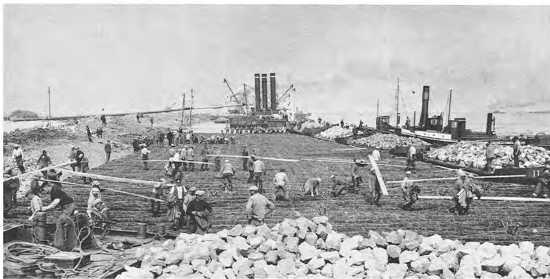
Kraagstuk voor de Afsluiddijk wordt voor afzinken in gereedheid gebracht.
