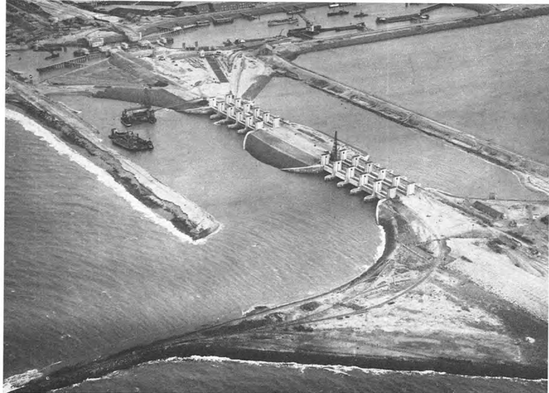
De uitwateringsluizen te Kornwerderzand; een gedeelte van de omringdam is weggebaggerd.
