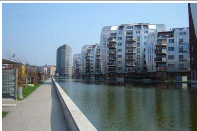
Figuur 21, Woningen aan vijver Den Bosch, eigen foto
