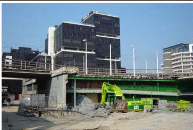
Figuur 24, Bouwwerkzaamheden Den Haag Centraal, eigen foto
