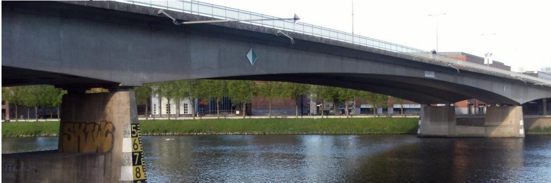
Figuur 2-6 de John F. Kennedybrug in Maastricht, met een hoofdoverspanning van 112 meter.
