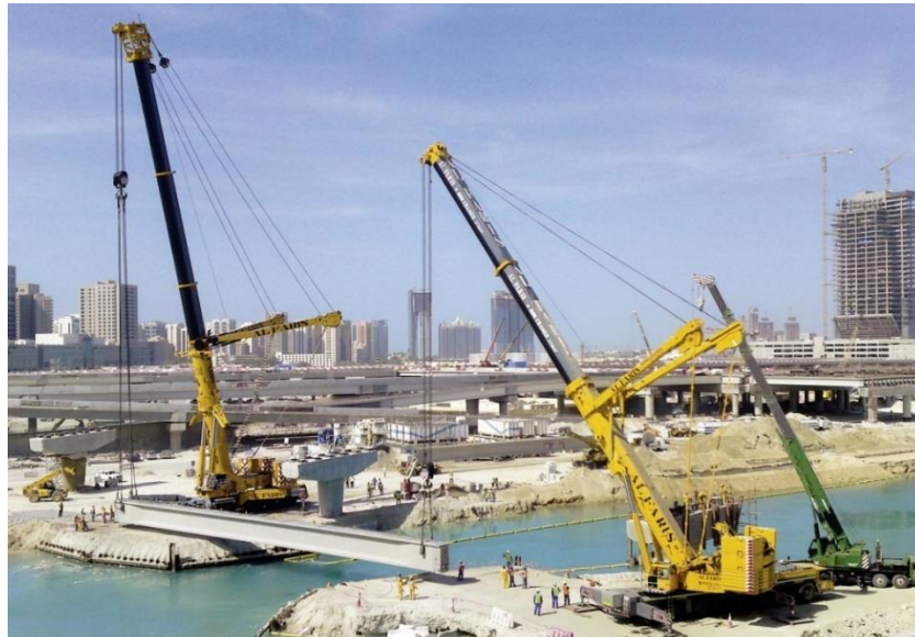
Figuur 10-51 een foto van twee mobiele hijskranen van het type Liebherr LTM 1500-8.1.
