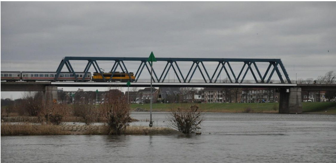
Figuur 2-3 de IJsselspoorbrug in Deventer met een overspanning van 96 meter.
