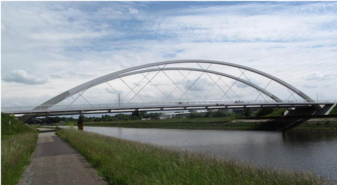
Figuur 2-9 de Polbrug over het Twentekanaal, met een overspanning van 117 meter.
