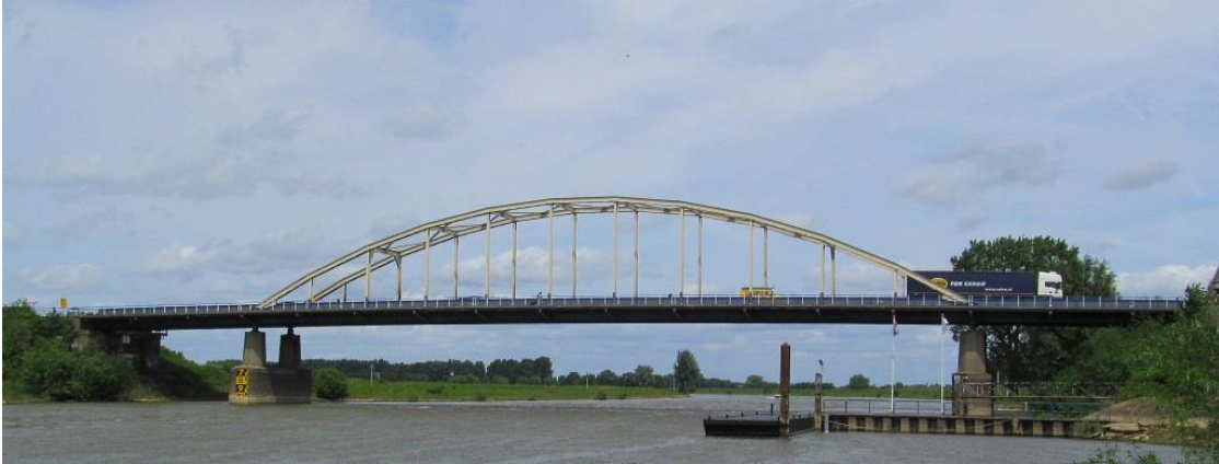
Figuur 2-2 de Doesburgbrug over de IJssel met een overspanning van 89 meter.
