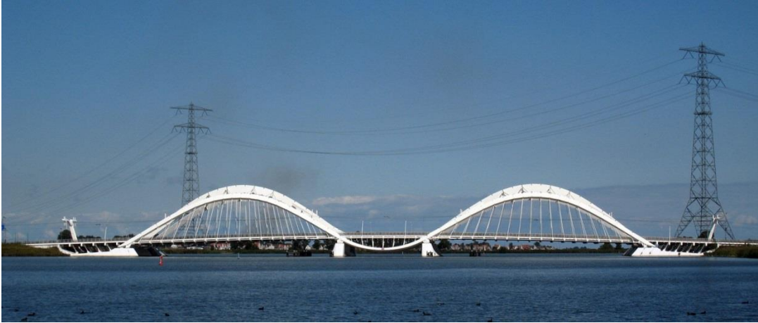
Figuur 2-10 de Enneüs Heermabrug In Amsterdam met twee hoofdovertoppingen van 75 meter.
