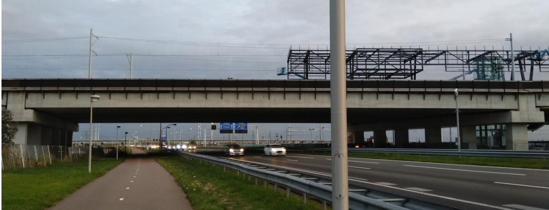
Figuur 1-3 het station Zoetermeer-Lansingeland in aanbouw, met de overspanning over de snelweg A12.
