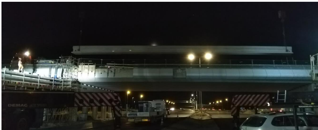
Figuur 1-2 Voorbeeld van een 's nachts uitgevoerde liggermontage waarbij gebruik wordt gemaakt van mobiele hijskranen.
