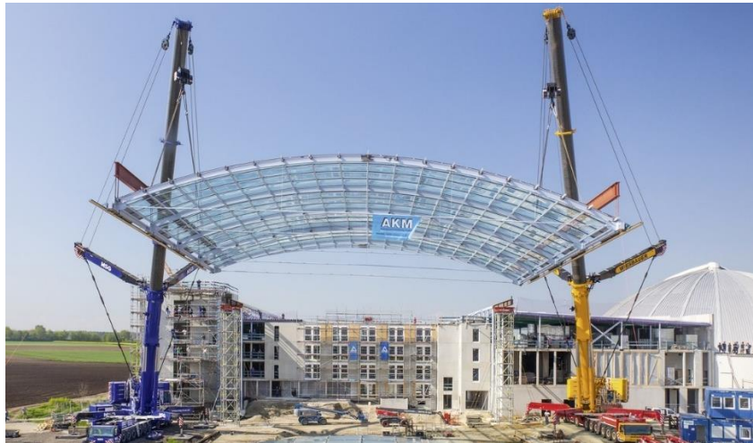
Figuur 10-50 een foto van twee mobiele hijskranen van het type Liebherr LTM 1750-9.1.
