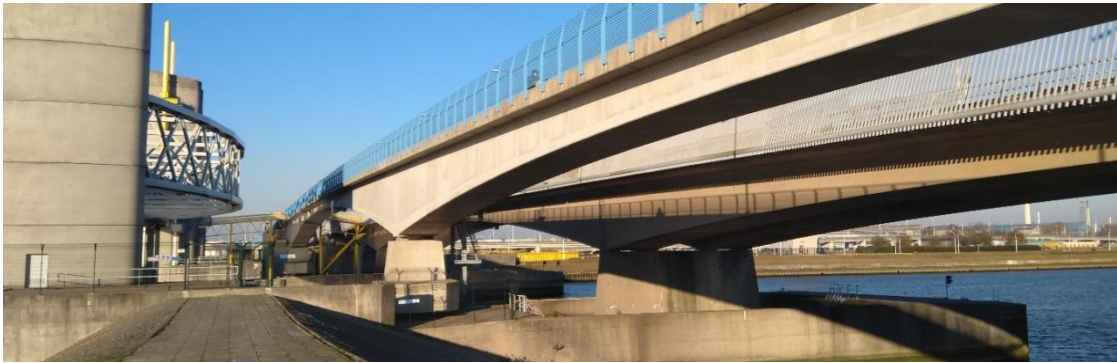
Figuur 5-6 de Hartelfietsbrug over het Hartelkanaal
