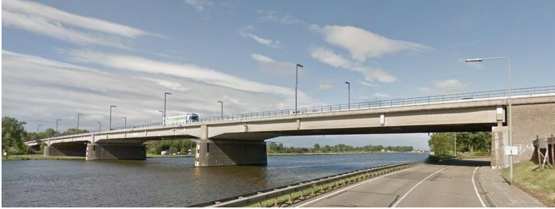
Figuur 2-8 de Louis Raemaekersbrug in Roermond met een overspanning van 80 meter.
