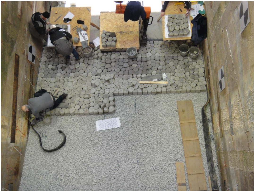
b) Opbouw model: plaatsen van steenzetting
