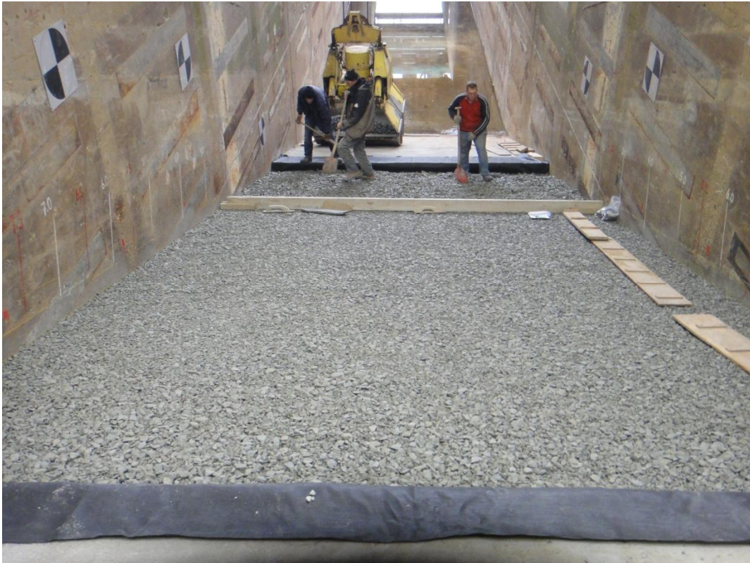
a) Opbouw model: aanbrengen filterlaag
