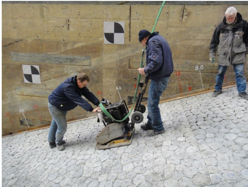
a) Opbouw model: inwassen van steenzetting (met trilplaat overheen)
