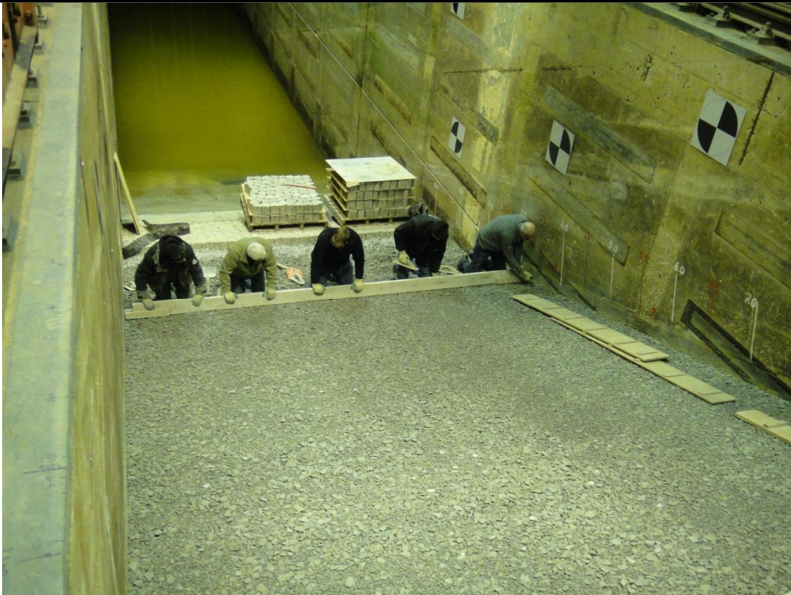
a) Serie 2: Herstel van talud (met nieuw filter en inwasmateriaal)
