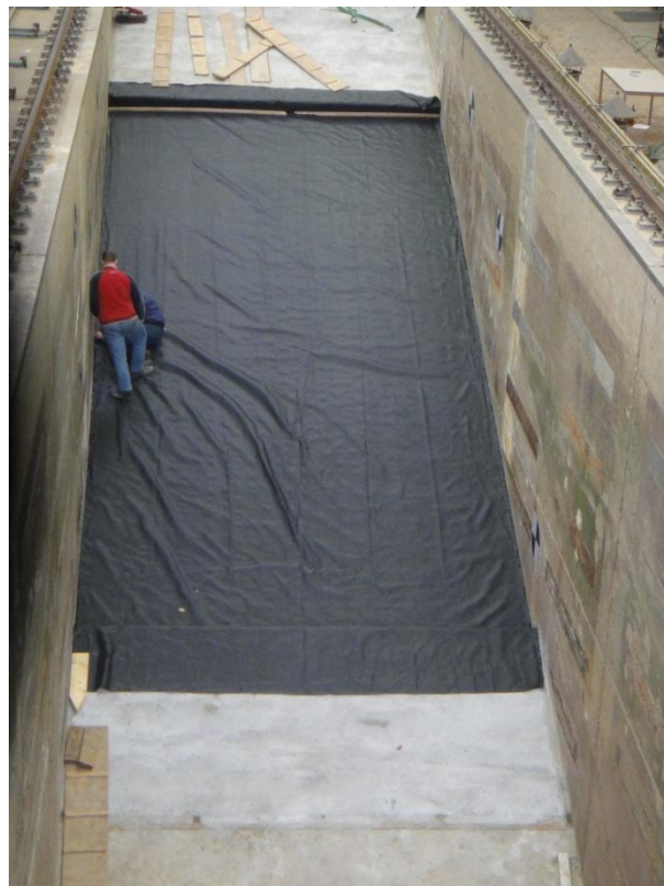
b) Opbouw model: plaatsen van geotextiel
