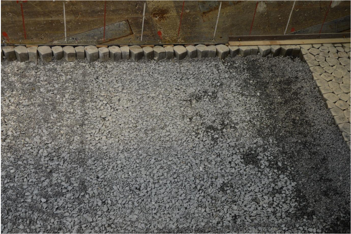
Serie 3: Na Proef 13 (aanzicht filter na verwijderen van steenzetting)
