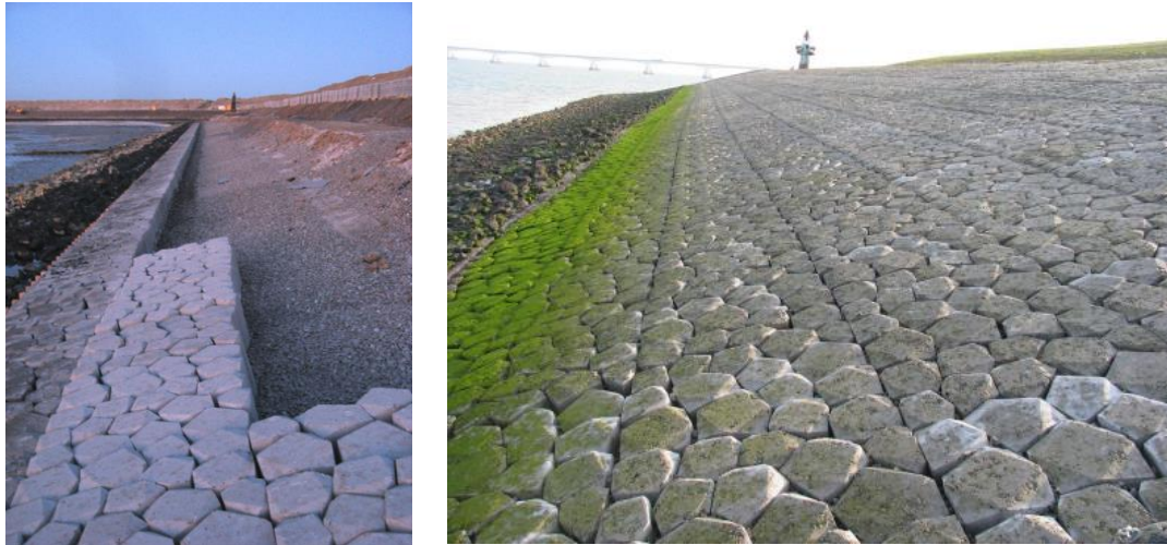
Figuur 3.2 Plaatsing van Basalton in het veld
