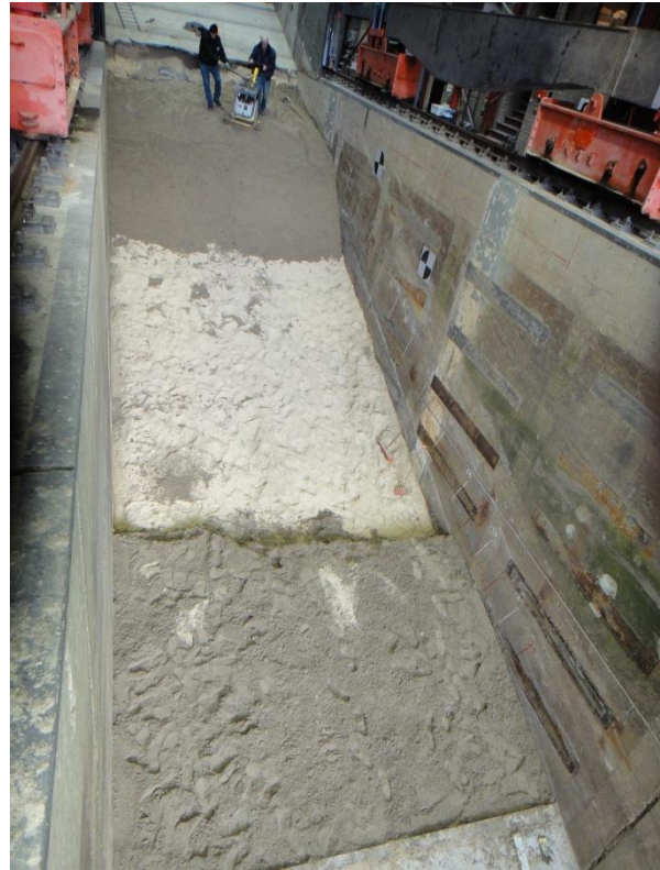
a) Opbouw model: aanbrengen zandcementstabilisatie
