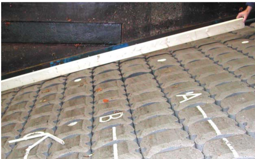
Figuur 7.4 Kattenrug in een steenzetting van Hydroblocks
