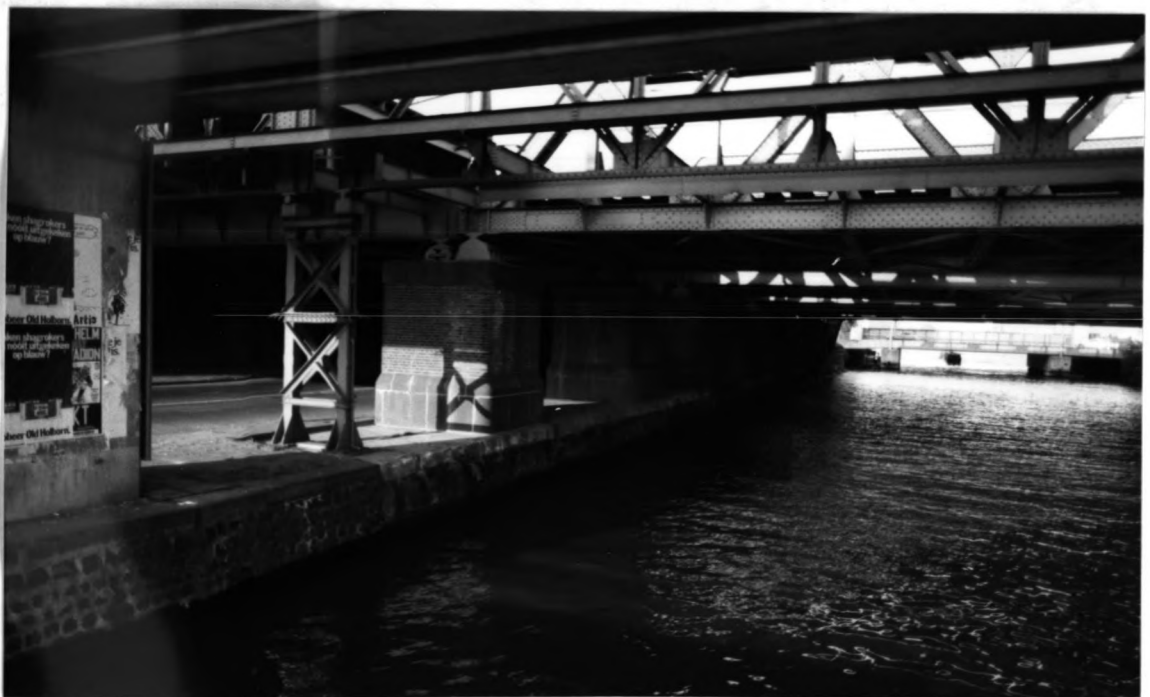
Foto 5 : Onder de spoorviaducten over de Oostertoegang. De ondersteuning is goed te zien. Op dit punt is de tunnel al ruim boven water. Rechtsachter is de nieuwe, vaste brug 486 te zien.
