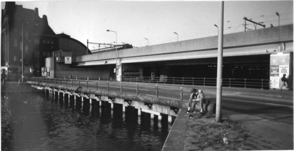
Foto 7 : Het zuidoende van de Oostertoegang. Vooraan de lage brug 228 naast de PTT-brug. Daarachter het Centraal Station.
