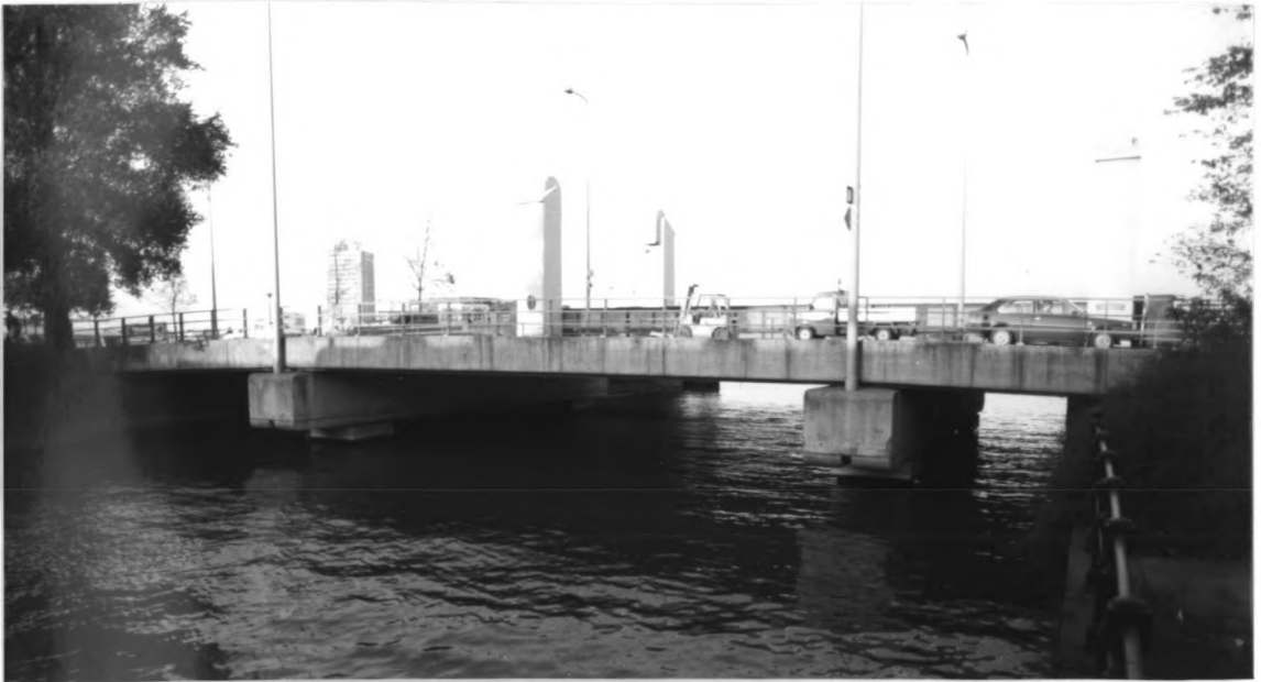
Foto 4 : De nieuwe, vaste brug 486 in de Ruijterkade. Daarachter ligt de oude hefbrug 276. Deze bruggen liggen over het noordelijk gedeelte van de Oostertoegang. Hieronderdoor moet de tunnel komen te liggen.
