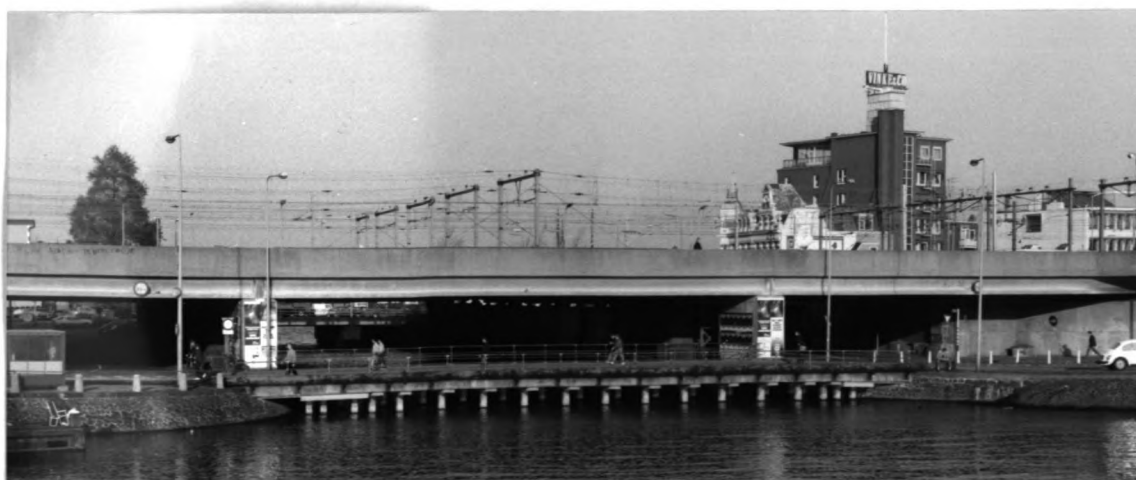
Foto 3 : De Oostertoegang vanaf het zuiden gezien. De tijdelijke brug 228 versperst de weg voor alle scheepvaart. De hoge betonnen brug is de verbindingsbrug voor de PTT. Als de tram hier onder uit komt, moet meteen een scherpe bocht naar het Centraal Station (links van de foto) worden gemaakt.
