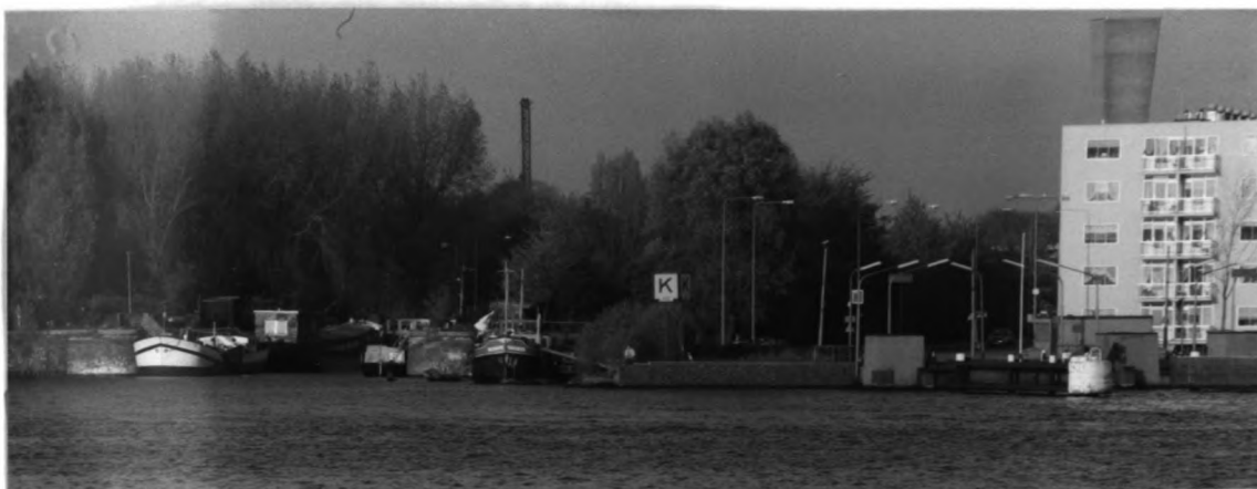
Foto 1 : De noordoever van het IJ. De schepen liggen in de voormalig schutsluis Willem III. De tunnel komt net rechts (oostelijk) van het K-bord aan land. Geheel rechts is de veersteiger en daarboven is één van de ventilatieschachten van de IJ-auto-tunnel te zien.
