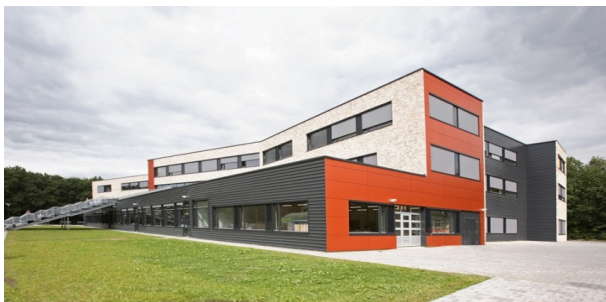
Figuur 53: zicht op gevel VMBO bovenbouw, bron: www.onderwijspaleis.nl
