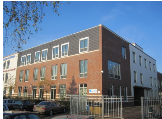
Figuur 36: zicht op gevel
