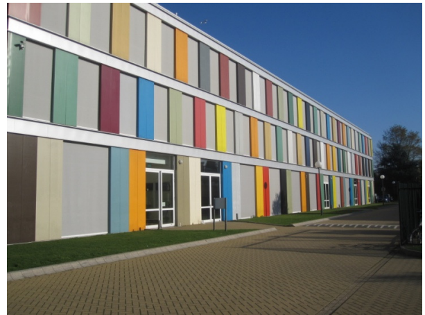
Figuur 25: zicht op gevel
