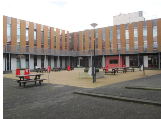
Figuur 19: zicht op gevel binnenplaats
