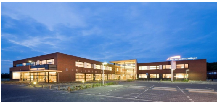
Figuur 57: zicht op gevel VMBO bovenbouw, bron: www.onderwijspaleis.nl
