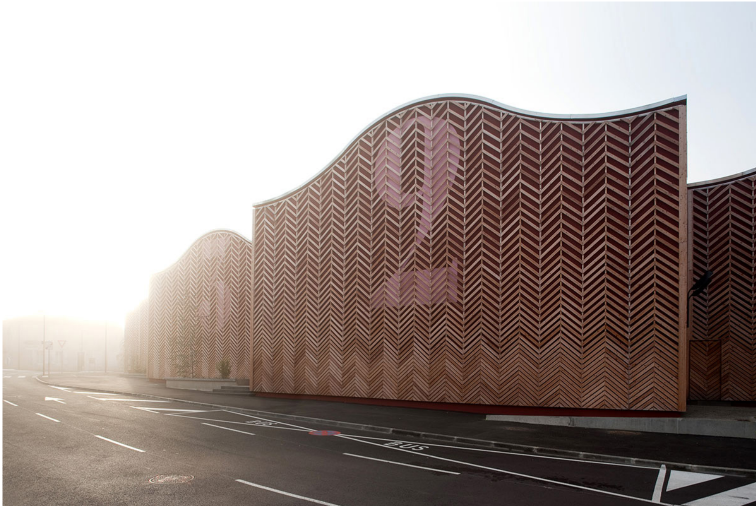
Encore Heureux (2012) Cinema Complex, Auch.
