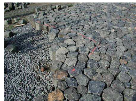
Fig. 9 Basaltic columns on a fill layer
