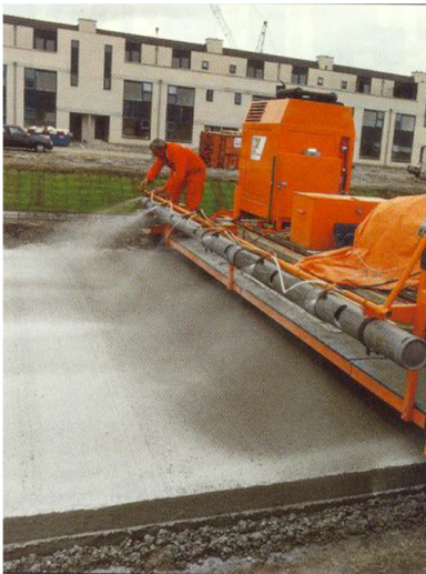
Figuur 116 Curing van betonoverlaging (Stet)
