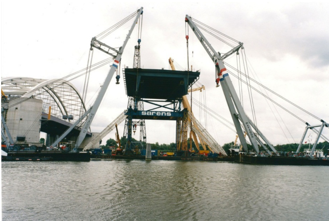
Figuur 7 Plaatsen van de nieuwe val van de tweede Van Brienoordbrug in 1998, http://beeldbank.rws.nl , Rijkswaterstaat
