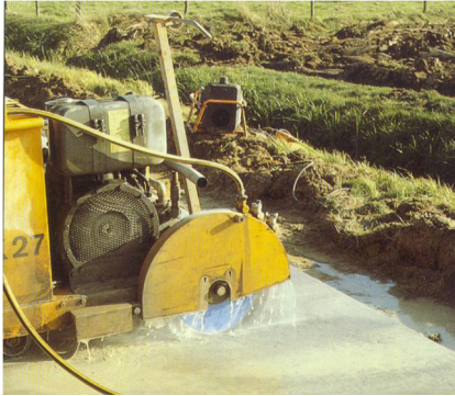
Figuur 115 Aanbrengen van zaagsneden (Stet)
