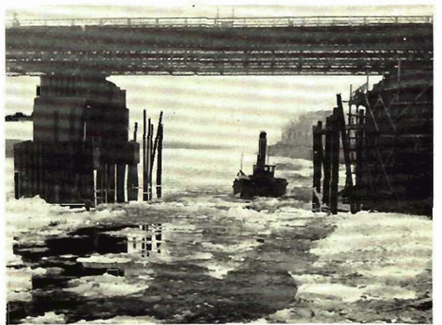
Doordat het ijs op de gehele Neder-Rijn gebroken was, werden bij de zeer snelle was van 9 maart 1947 de pijlerjukkens van de Baileybrug bij Arnhem niet beschadigd
