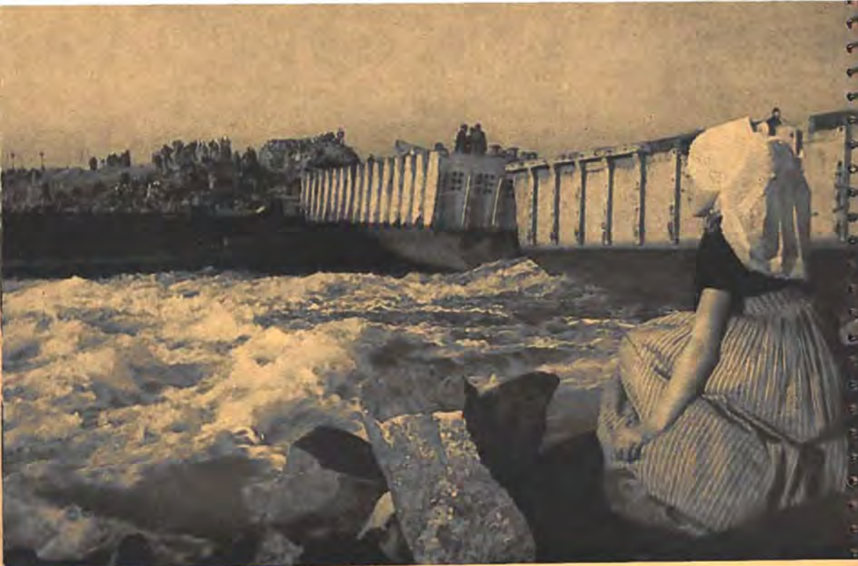
2 October 1945: de sluitgeul van het gat bij Westkapelle is geblokkeerd door twee groote caissons en drie kleinere. De overblijvende sleuven werden gedicht met steen, puin, torpedonetten en zand. (Foto Henning-Middelburg)
