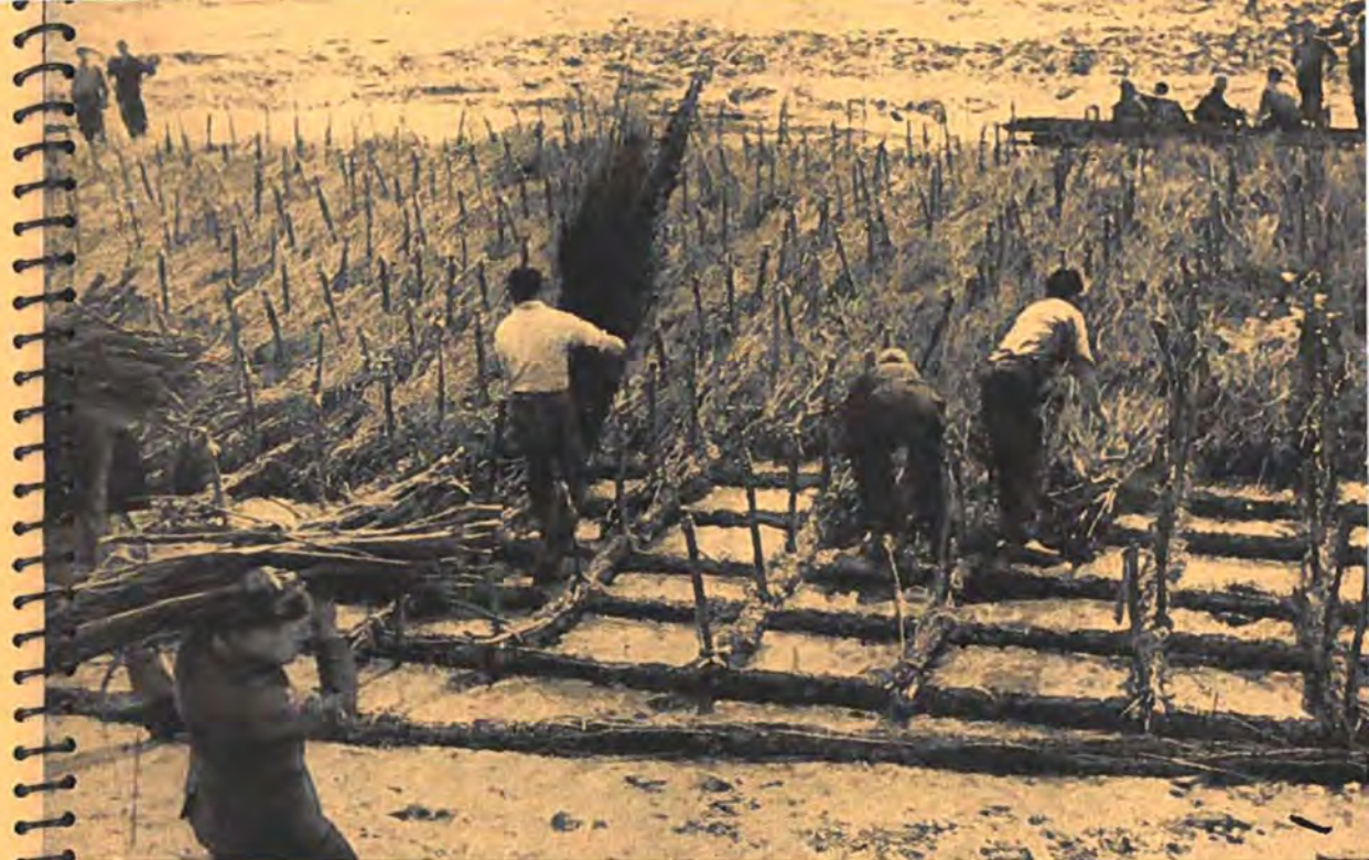
De eerste der drie lagen rijshout wordt op het onderrooster van het zinkstuk gelegd.
