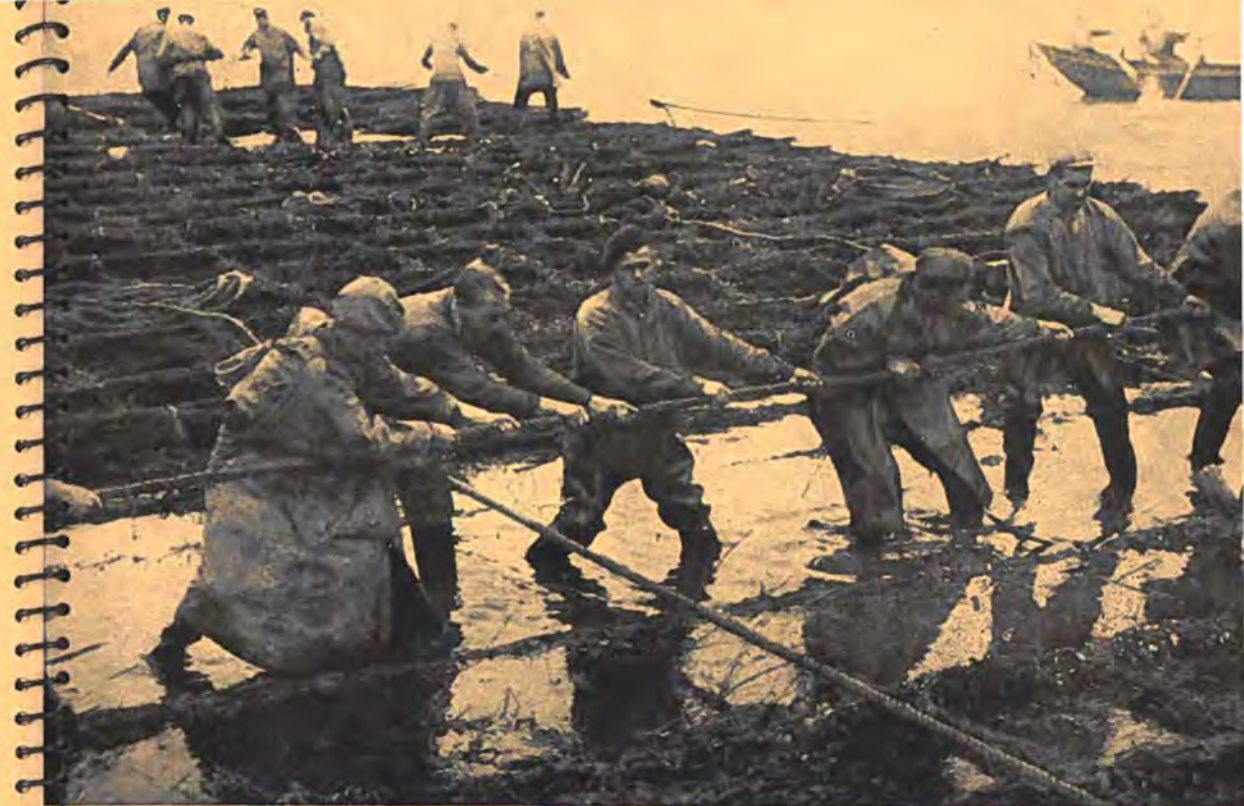
Het zinkstuk wordt „in den raai“ getrokken.
