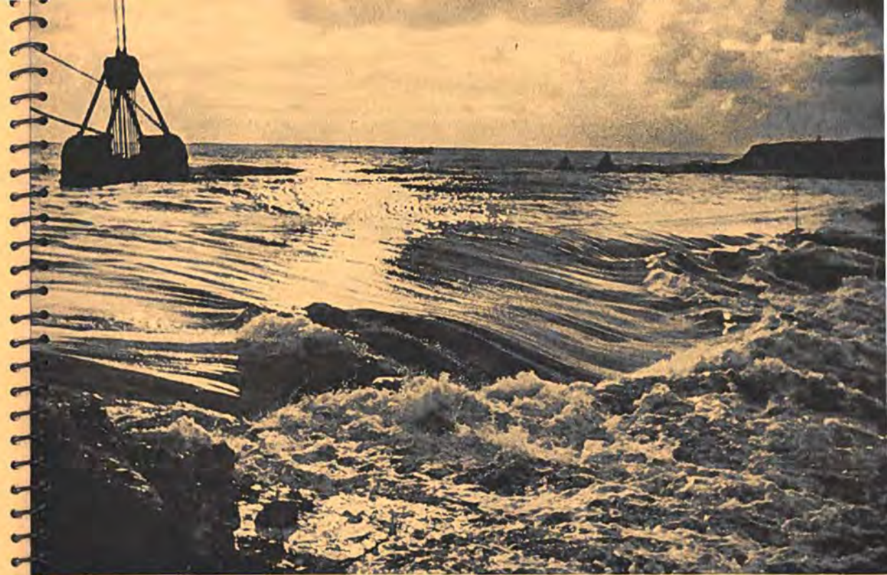
De tweede doorbraak van den Nollendijk op 27 September 1945. Let op de „overstort“ van het bij vloed binnenstroomende zeewater. Dit verschil in waterhoogte binnen en buiten (bij eb natuurlijk omgekeerd) veroorzaakt groote snelheden van het in- en uitstroomende water, waardoor de bodem der geul sterk wordt aangevreten.
