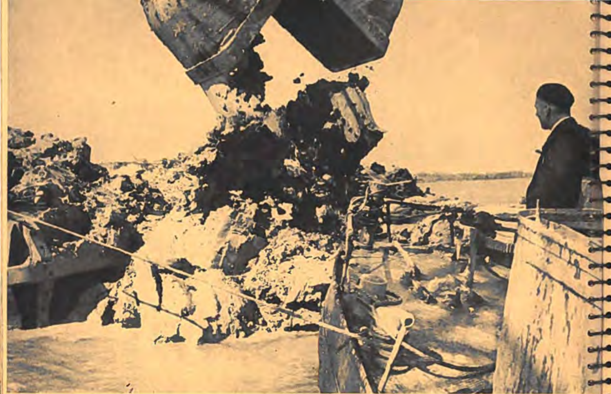
Nollegat, 2 September 1945: dichting van de voorlaatste geul. Van opzij gezien.
