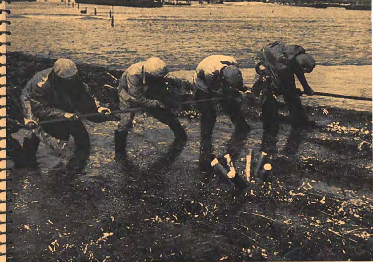
Het zinkstuk wordt „in den raai” getrokken.
