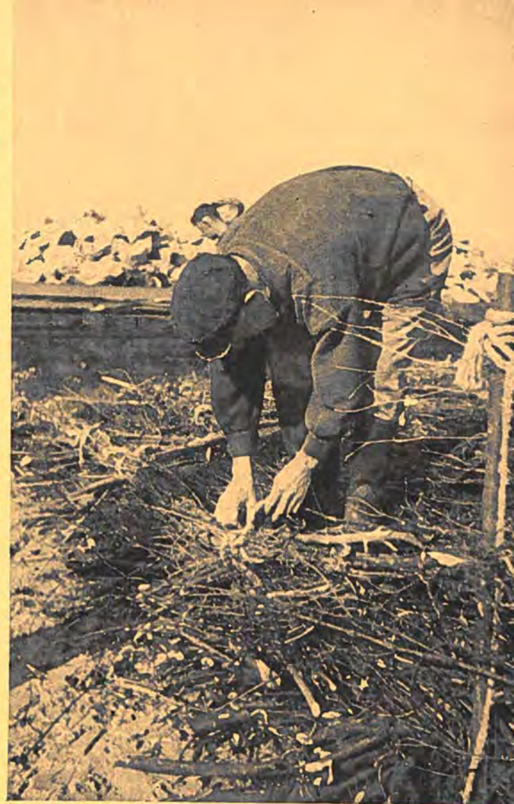
Onder- en bovenrooster van het zinkstuk worden met elkaar versnoerd.
