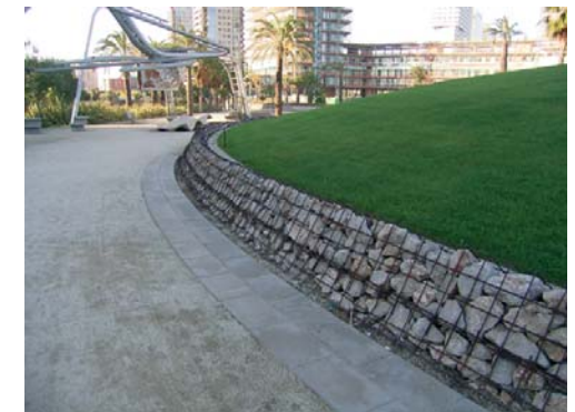
Parc Diagonal Mar Referentie Barcelona
