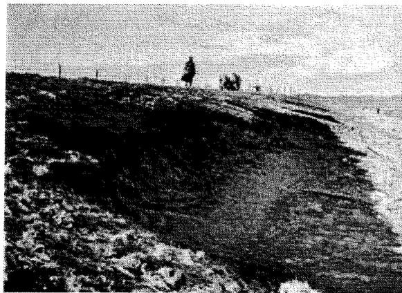
Abb.1: Schwerer Schaden an der Außenböschung (Ingenieurkommission 1962)
