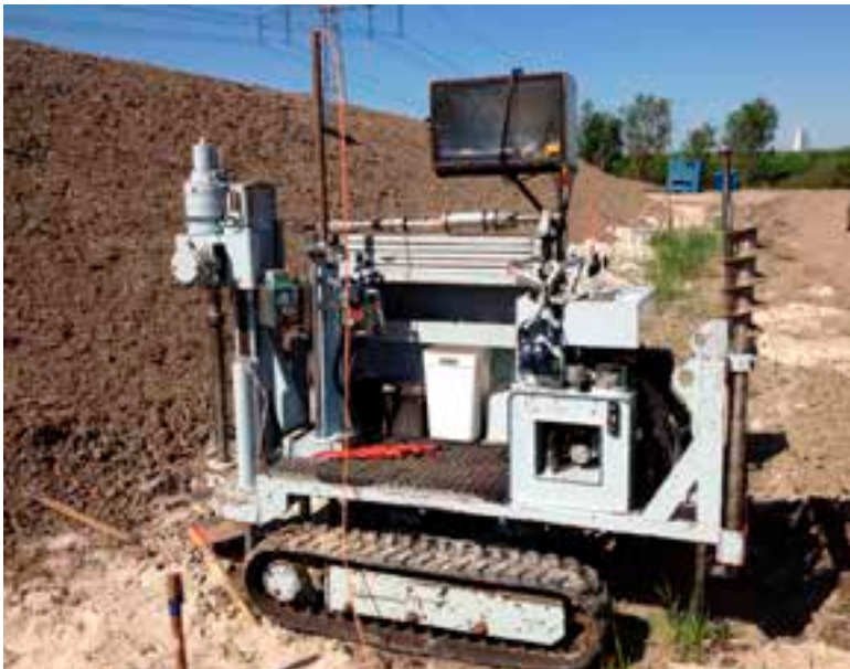
Plaatsing multi-sensormodules door mini sondeerrups
