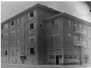
Bosleeuw: WA2 (metselwerk met gaten)
