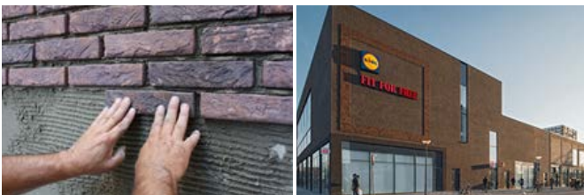
Figuur 8: Keramische steenstrips, links dichtbij (Van der Sanden, 2019), rechts ver weg (Van der Sanden, 2019)
