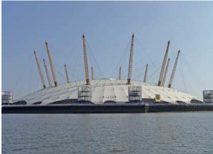
FIG. 45 Millennium Dome/O2 Dome, London
