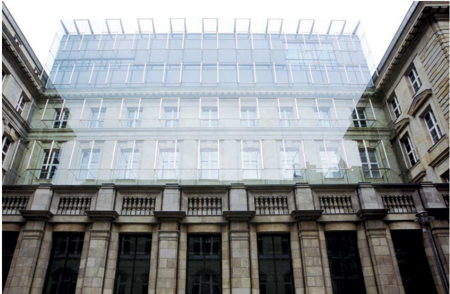
FIG. 88 Façade of the Deutsche Bank unter den Linden in Berlin, architect: Novotny and Mähner
