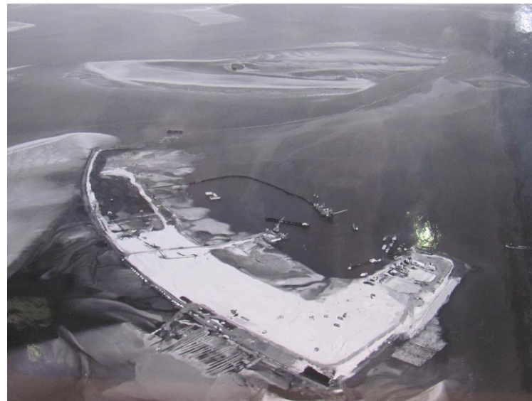
Figure 5.2 - Close-up Middelplaat (Rijkswaterstaat, 1965)
