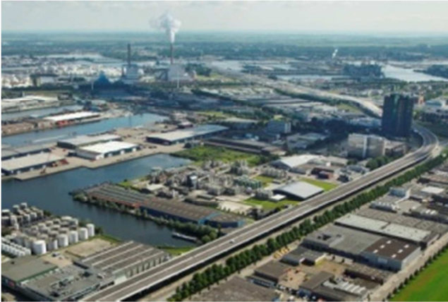
Fig.2.1 Bird view on the Westrandweg (Rijkswaterstaat,2013)
