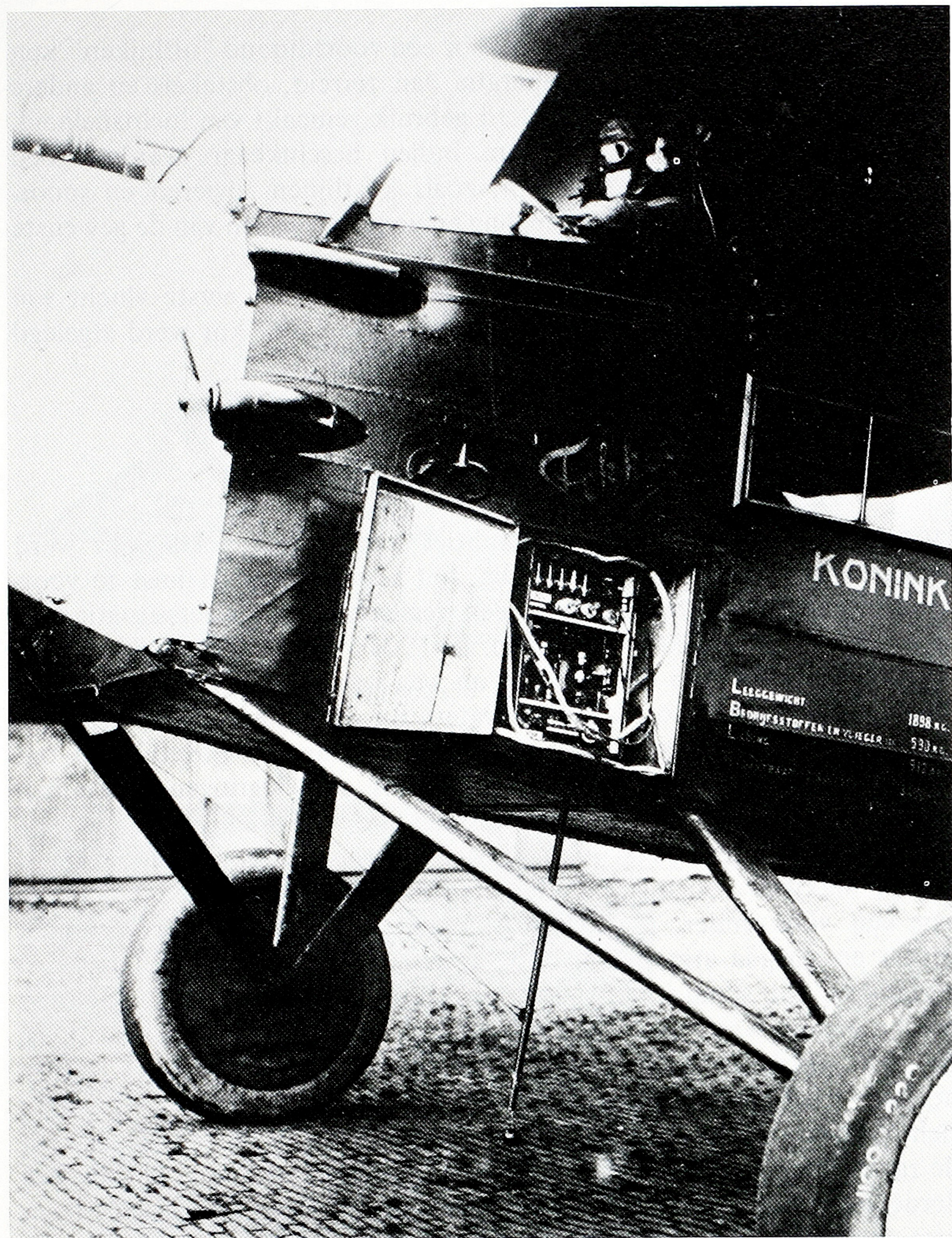
Figuur 3 — Radiocommunicatieapparatuur in de Fokker F VII (1924)
