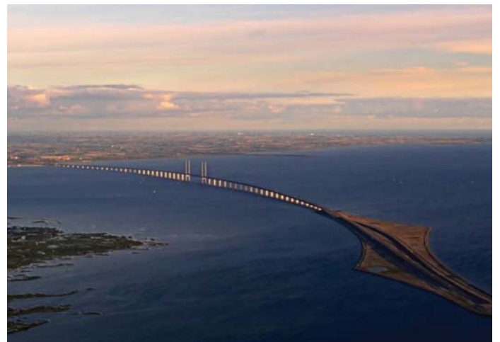
Fig. 5 The Øresund bridge
