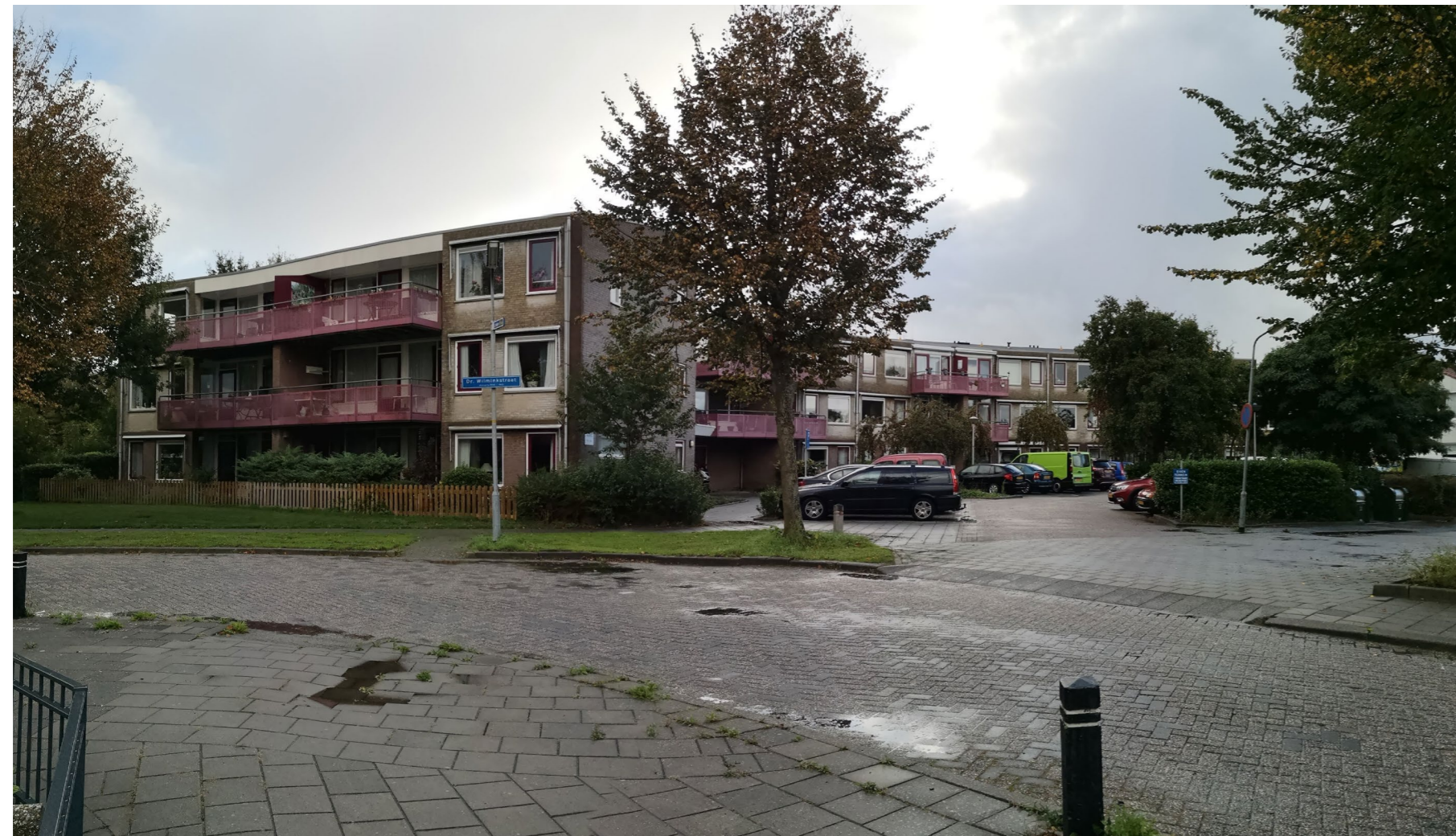
Woningcomplex BuitenZorg, Zuid-Scharwoude (eigen afbeeldingen)
