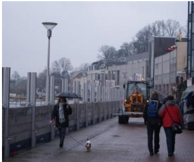
Figuur 6-1 De mobiele waterkering in Nijmegen.
