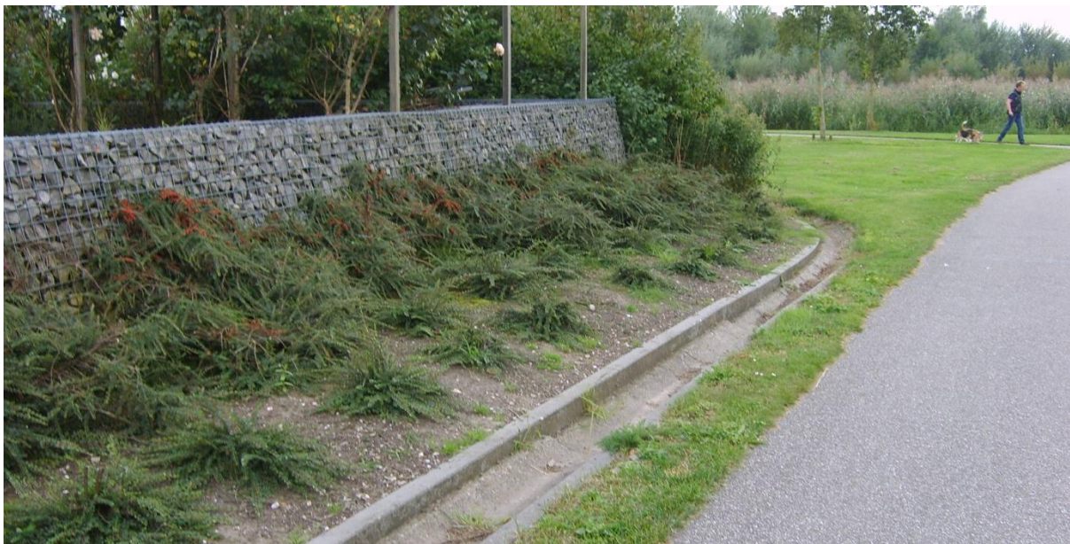
Figuur 3-9 Stroomgoot in de wijk Laag Dalem.
